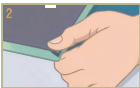
2. Comece pela parede oposta à entrada. Posicione o primeiro painel com o lado fêmea para a parede. Utilize espaçadores para manter um espaço de dilatação de 5 mm entre o piso e a parede.
