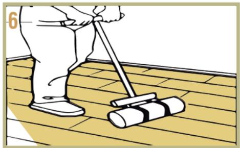
6. Após a instalação de todas as peças, passe um rolo de 50 a 70 kg sobre o piso para garantir que todos os painéis estejam bem fixos. Reinstale os rodapés removidos e pronto!
