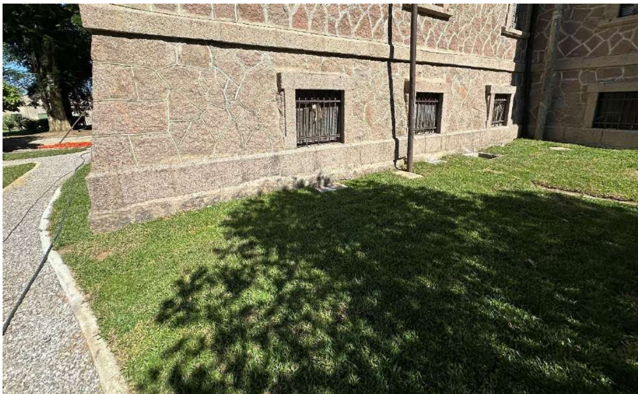
Foto 24 – Colocação de grama São Carlos.
