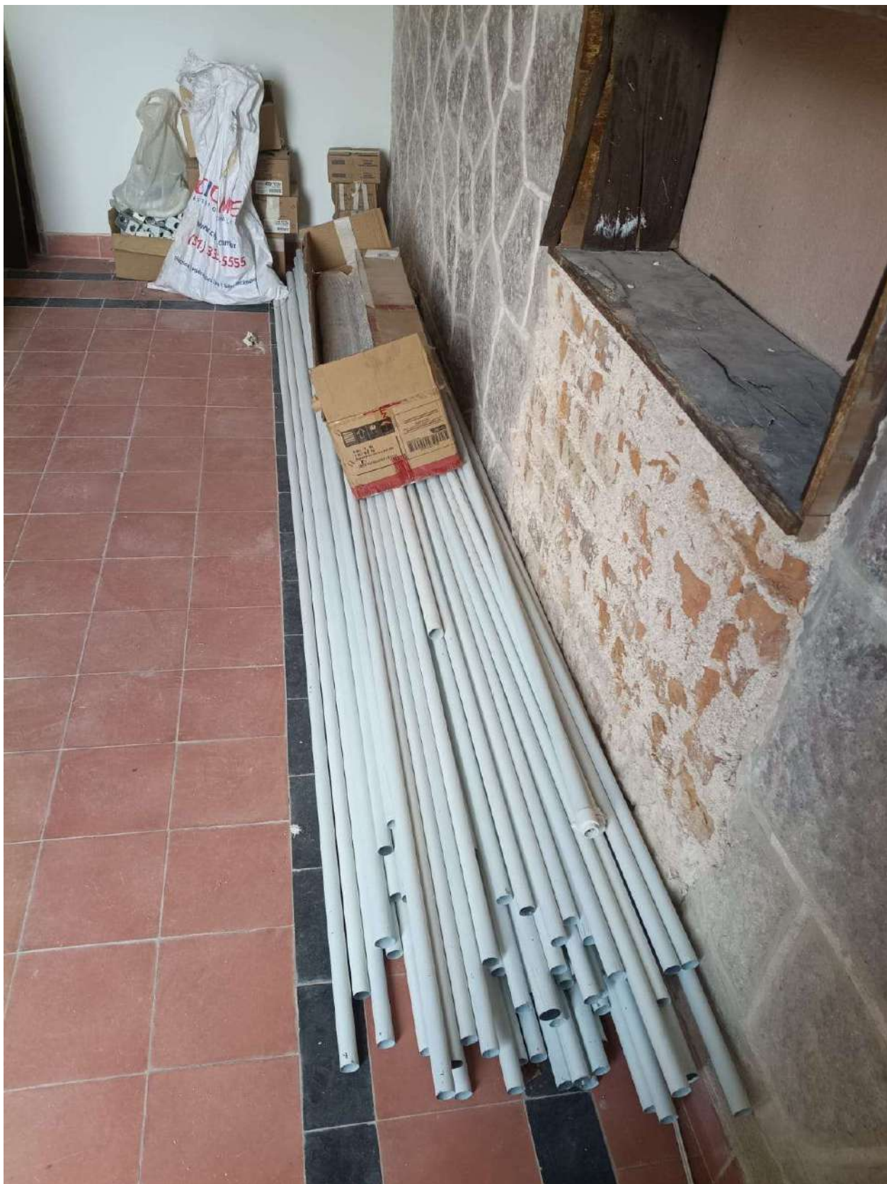
Foto 38 – Instalações elétricas removidas.
