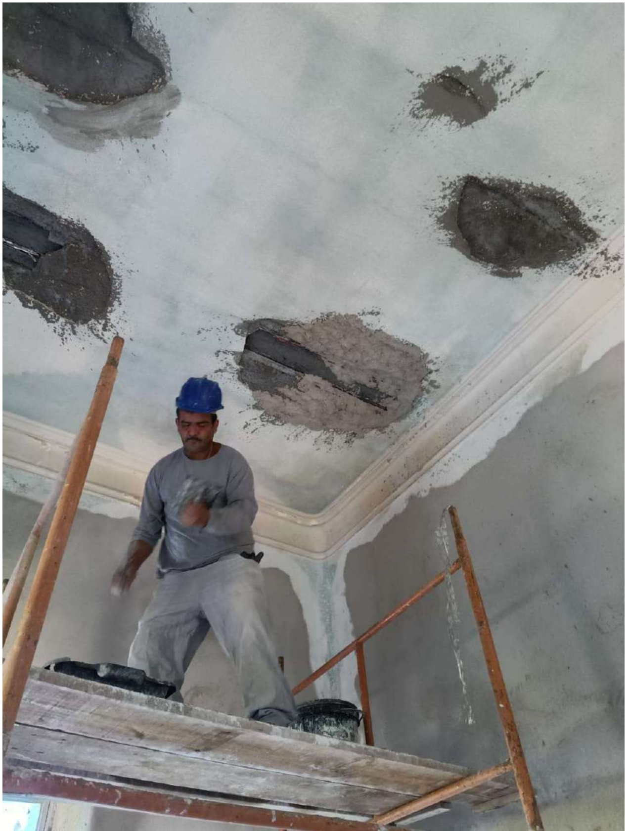
Foto 14 – Recuperação dos elementos metálicos do teto, e reintegração do reboco.
