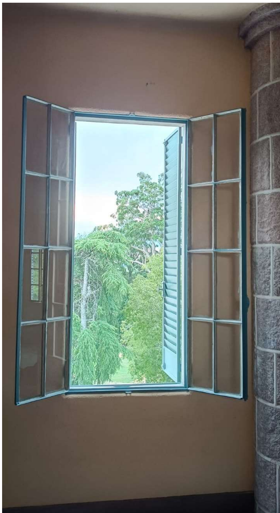
Foto 94 – Repintura janelas metálicas.
