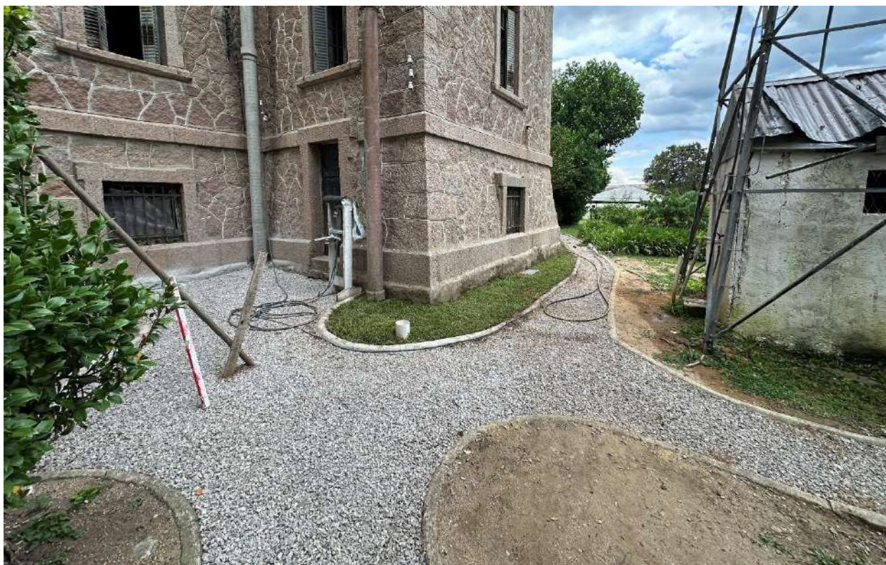
Foto 26 – Reconstrução dos cordões e caminhos com brita.
