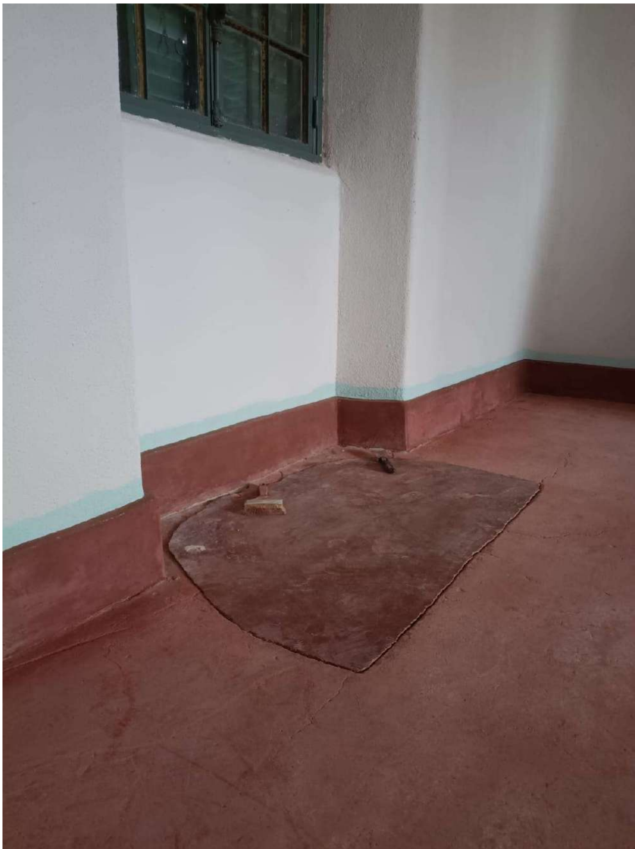
Foto 64 – Reintegração rodapés C39 – 2. Nível. Limpeza pisos.
