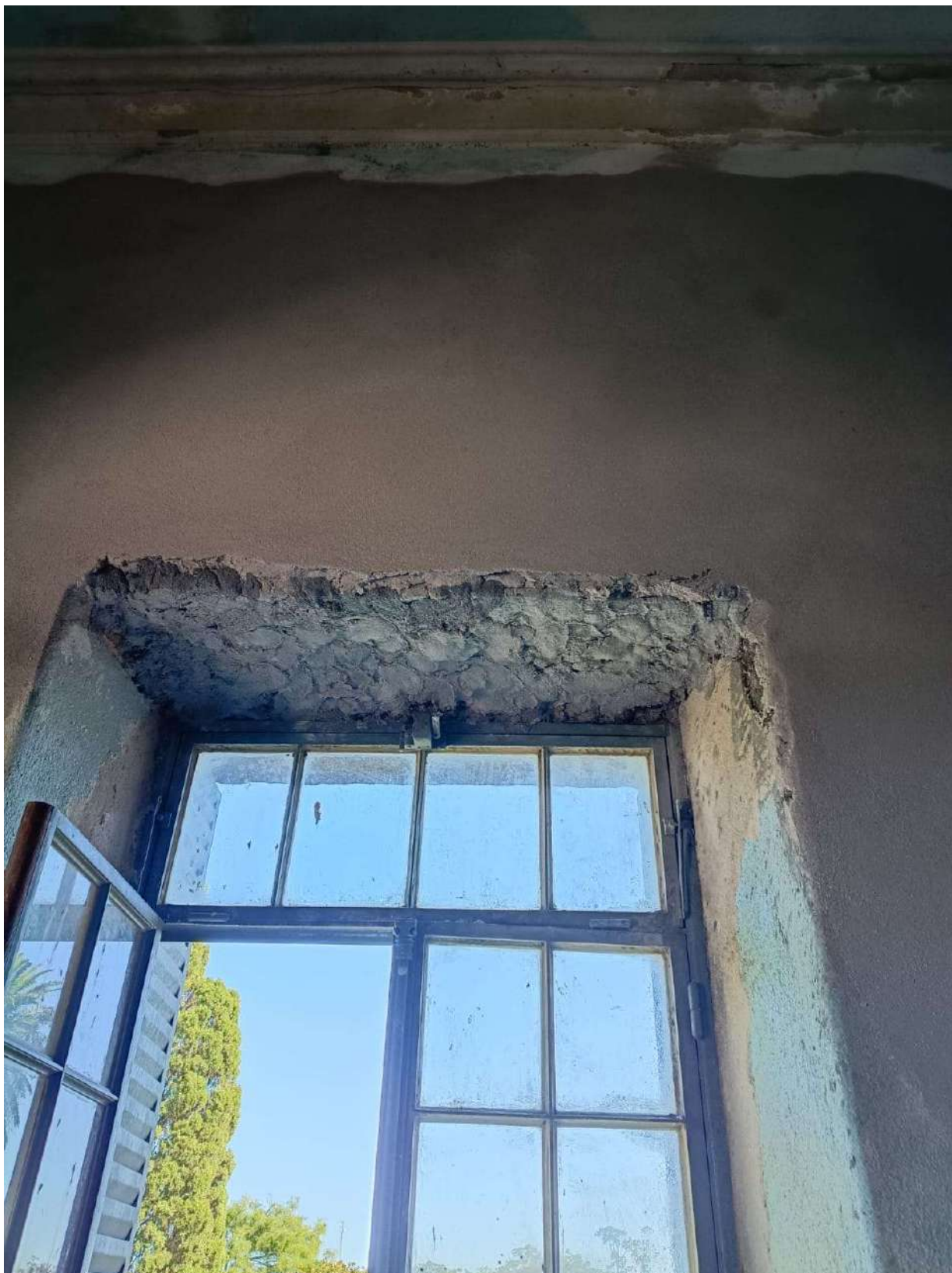
Foto 13 – Recuperação das peças metálicas das vergas das janelas, colocação de tela de estuque e reconstituição do reboco.
