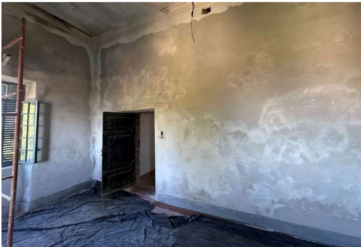
Foto 8– Execução rebocos.
