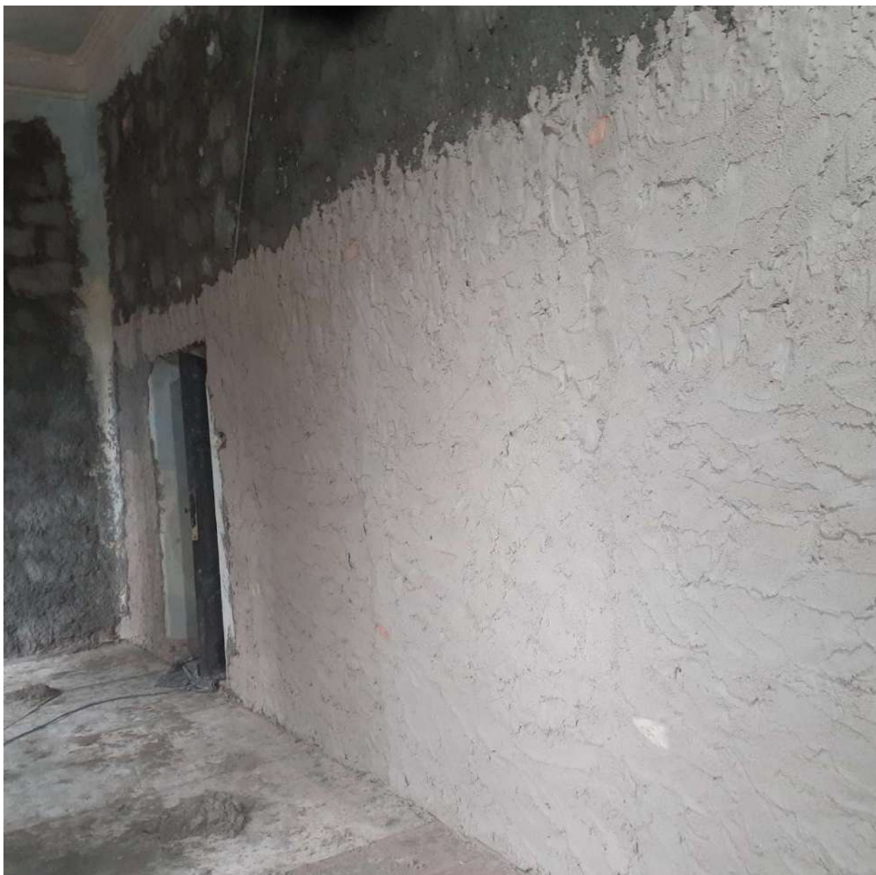
Foto 6 – Execução reboco.
