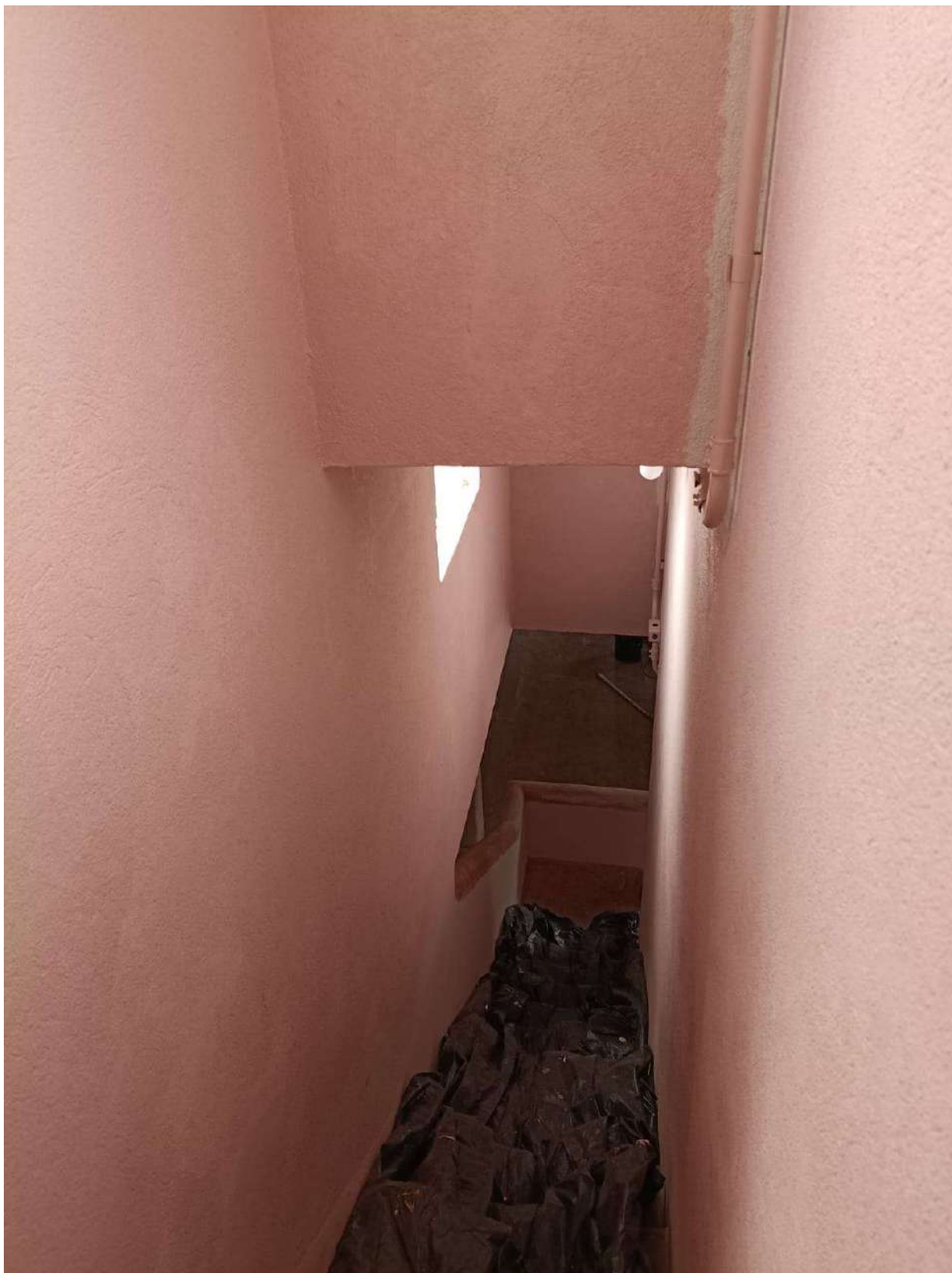
Foto 52 – Pintura paredes e tetos.
