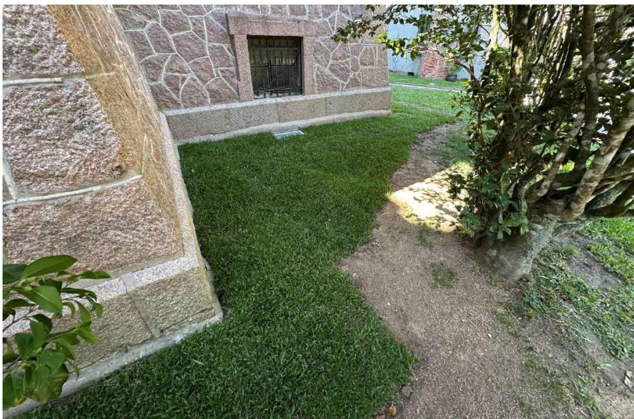
Foto 23 – Colocação de grama São Carlos.
