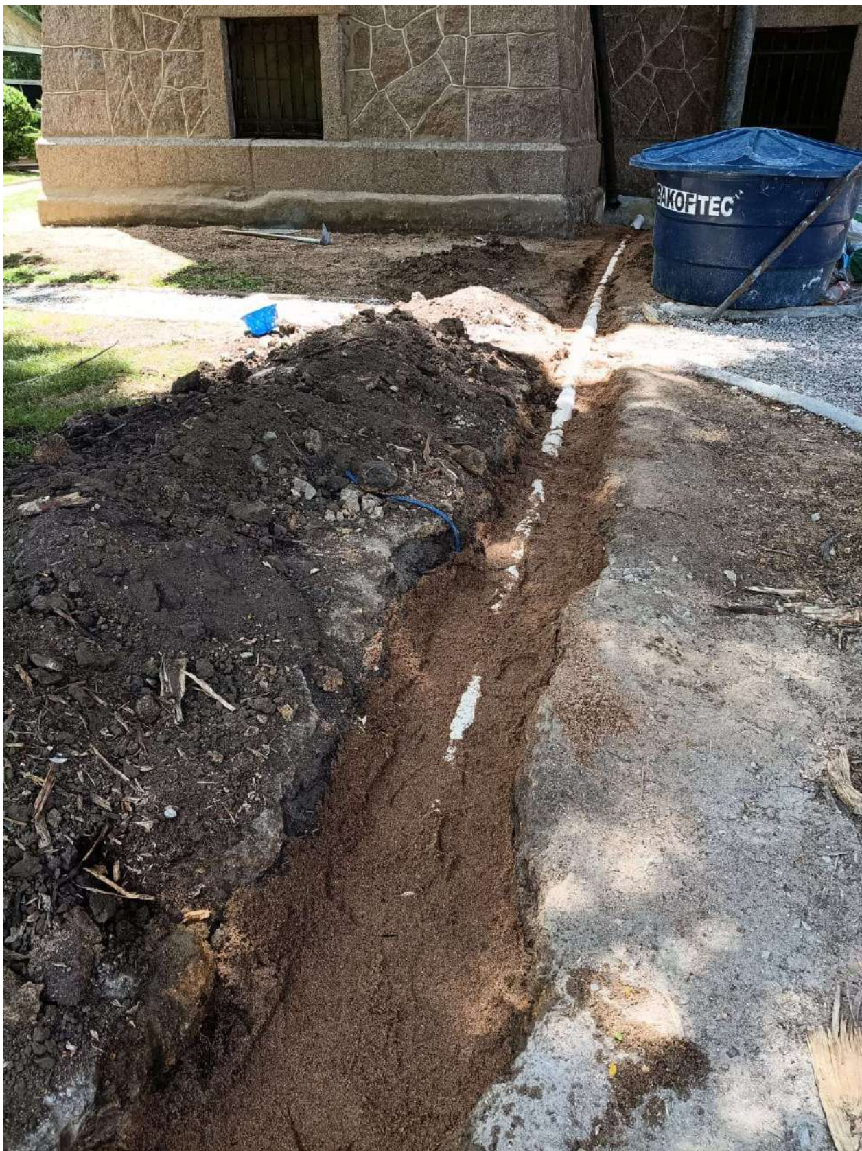
Foto 32 – Rede PVC 00 mm da caixa de inspeção do castelo até a fossa.
