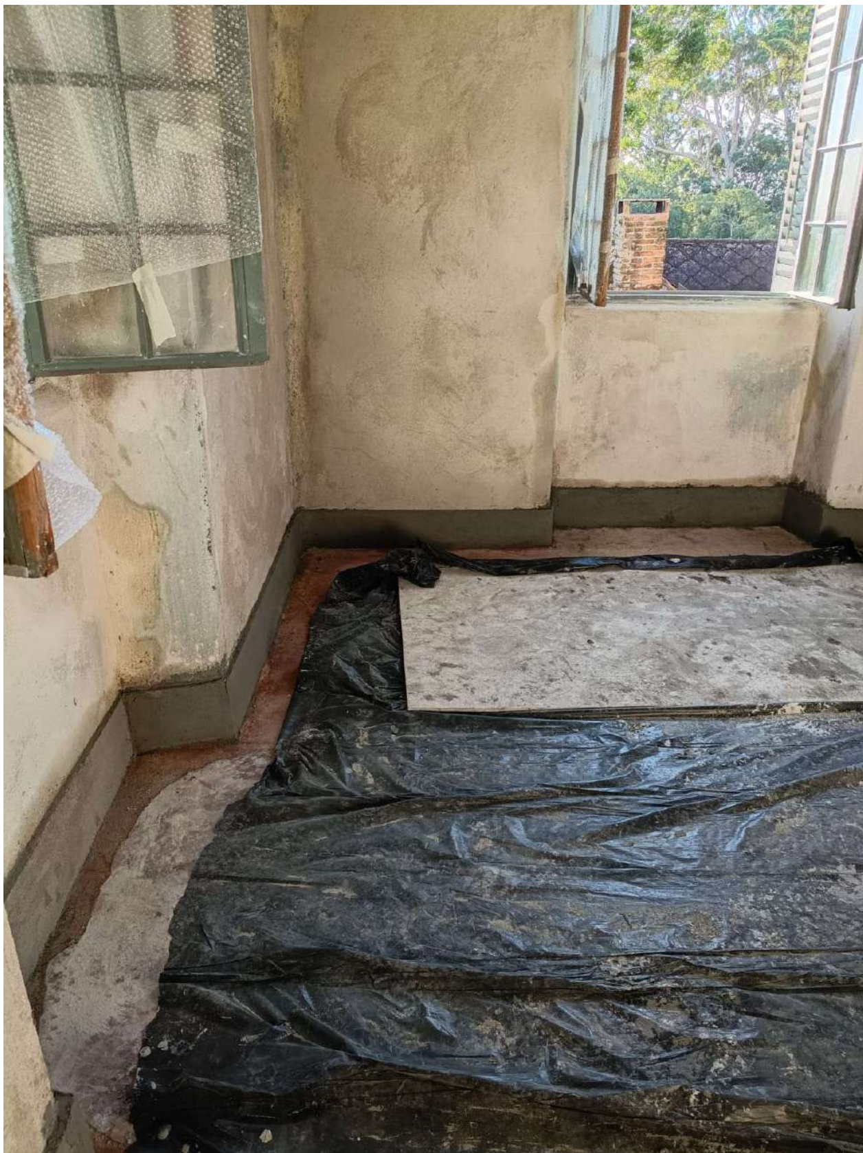
Foto 62 – Reintegração dos rodapés – Dormitório 1 – C27.
