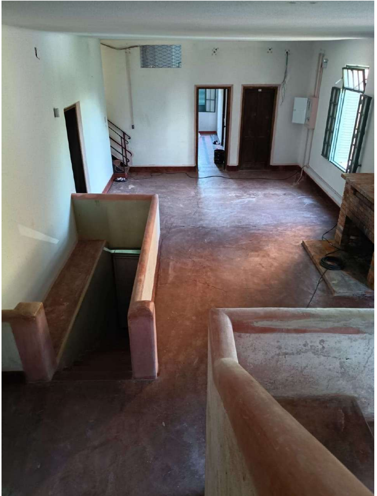
Foto 66 – Limpeza piso 2. Nível C33.
