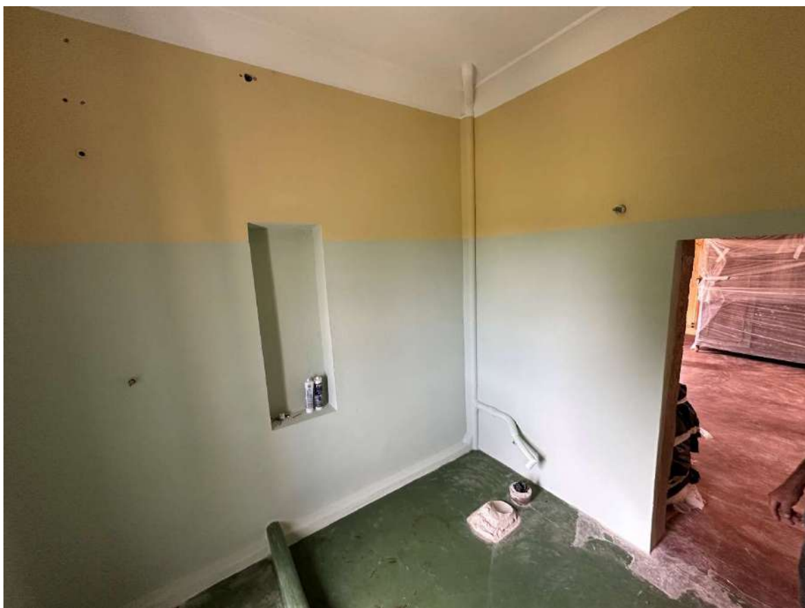
Foto 44 – Pintura paredes e tetos.
