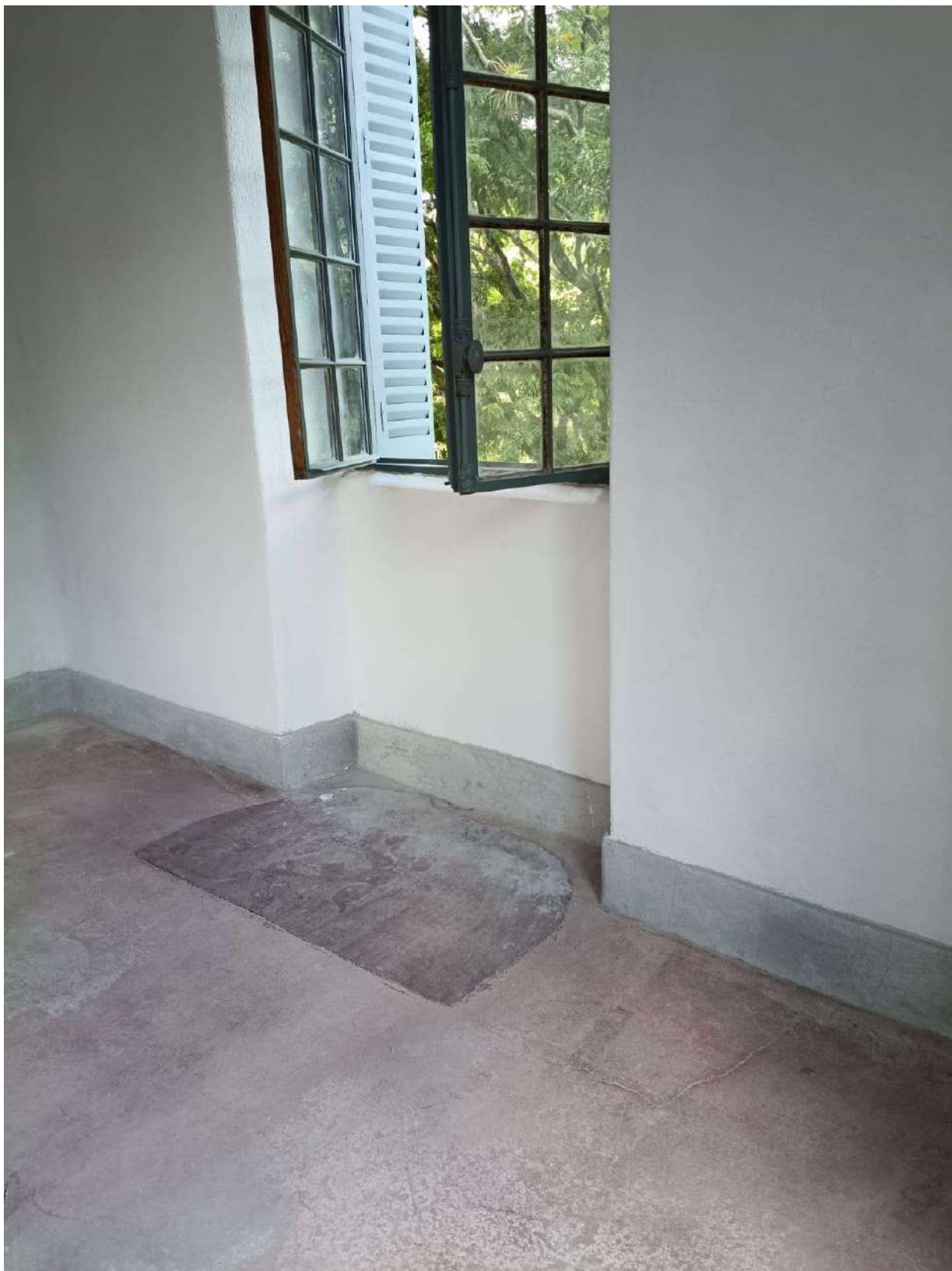
Foto 63– Reintegração rodapés C39 – 2. Nível.
