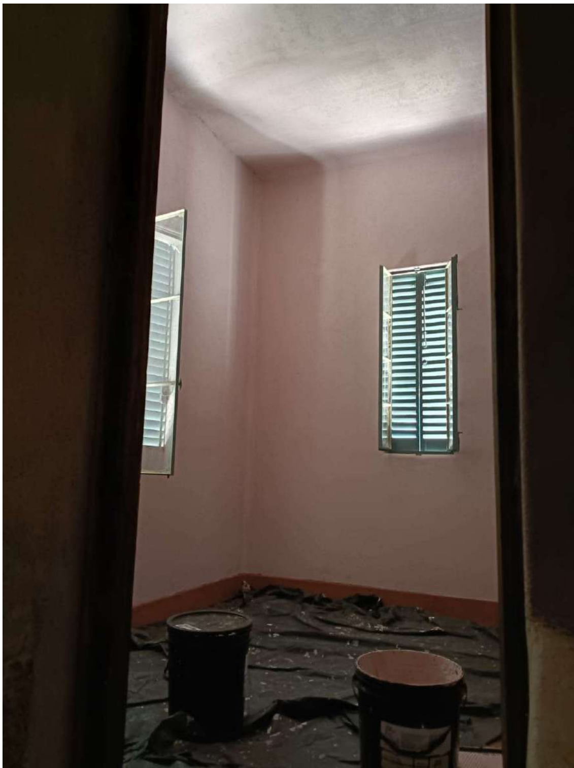
Foto 39 – Pintura tetos e paredes – Cor Couro Rosado – Tintas Coral.
