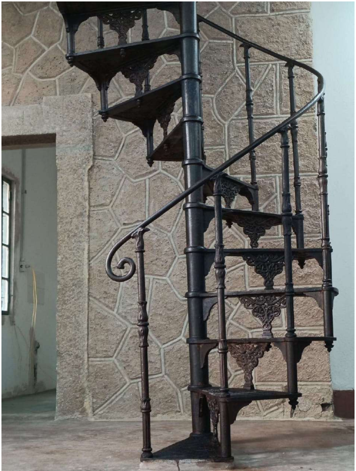
Foto 74 – Limpeza e aplicação de acabamento na escada.
