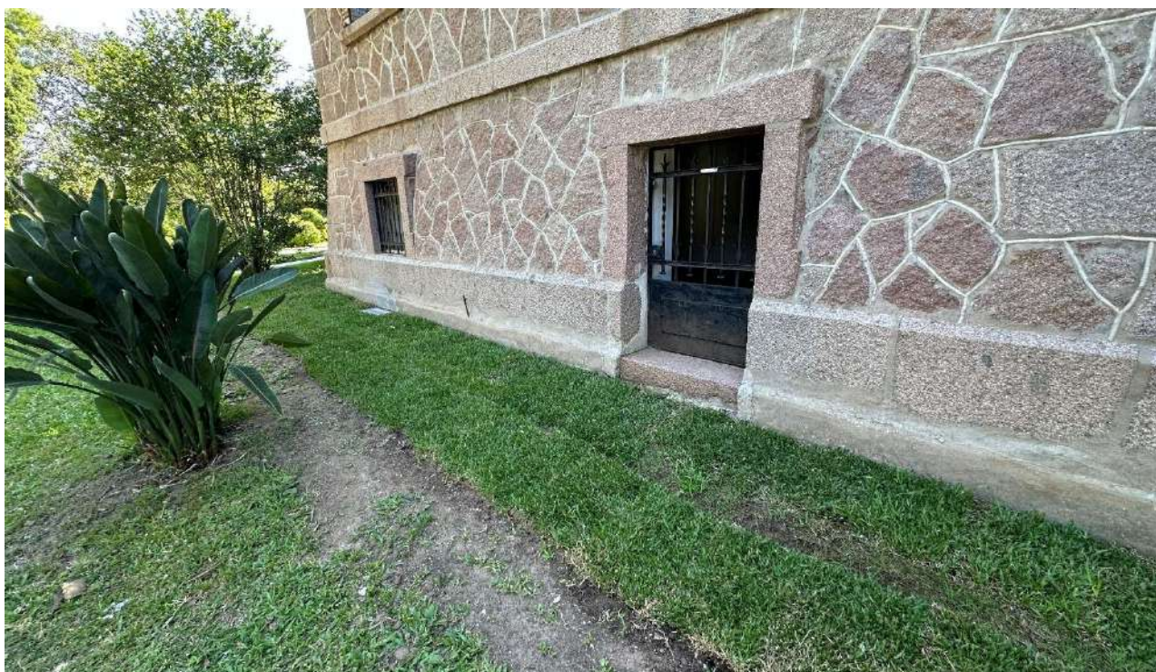
Foto 21 – Colocação de grama São Carlos.
