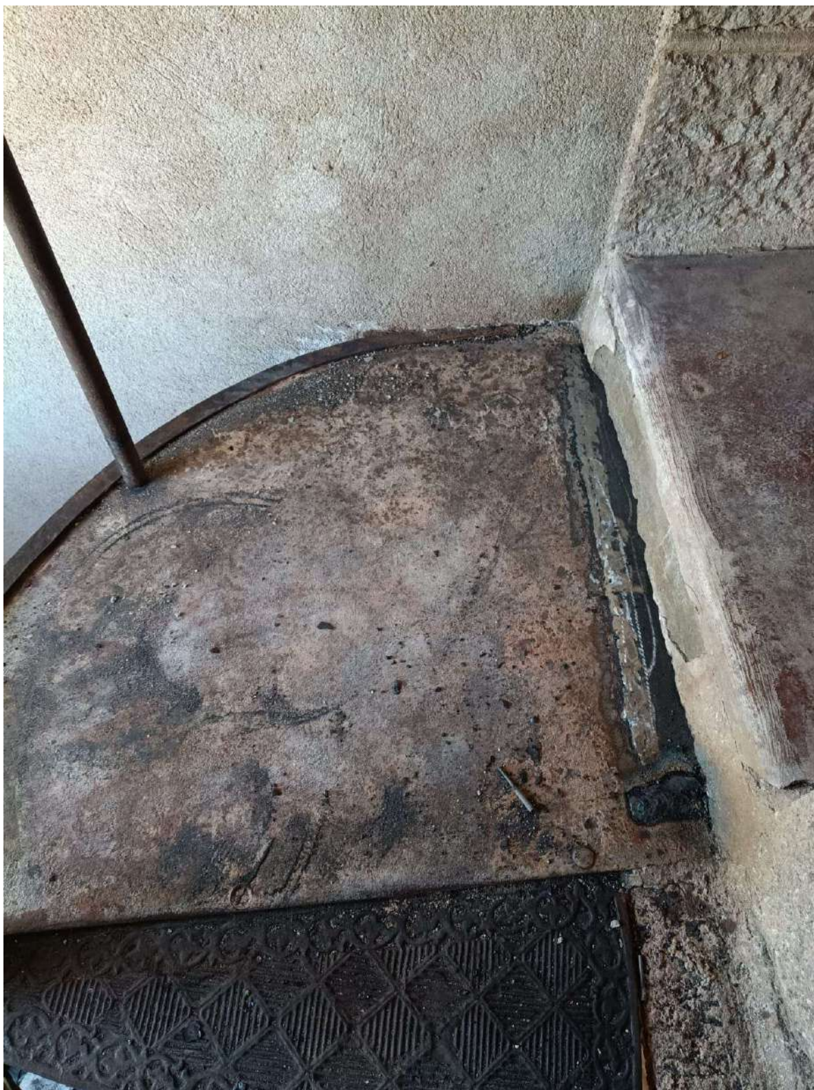
Foto 72 – Correção da parte degradada do patamar.
