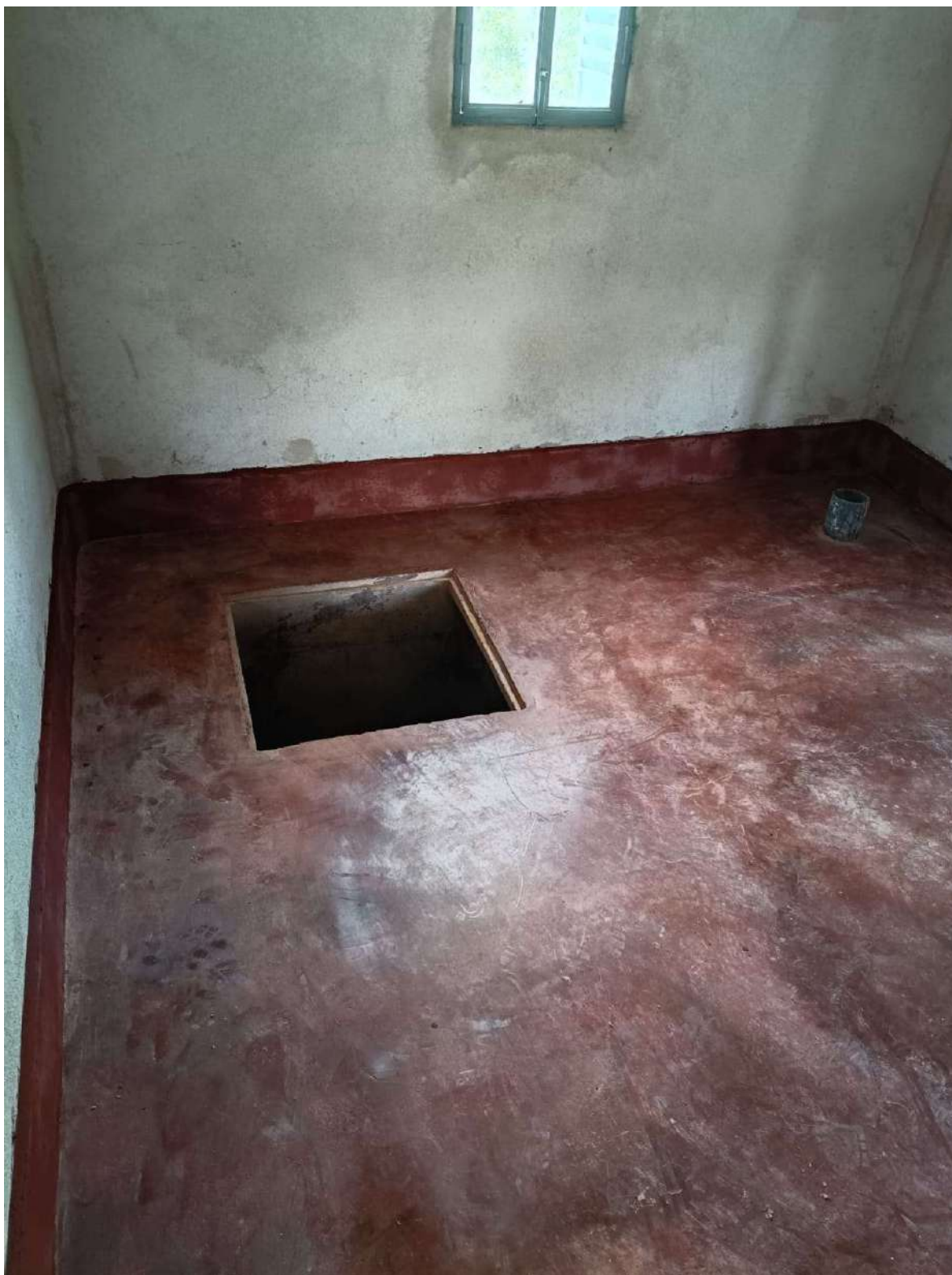
Foto 60 – Reintegração dos rodapés, limpeza piso 4. Nível. C52.
