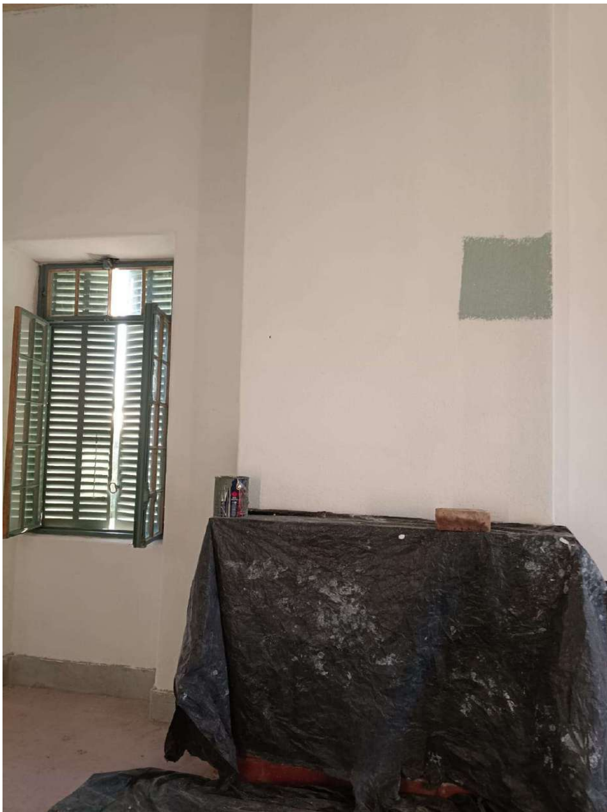
Foto 97 – Proteção lareira com lona plástica.
