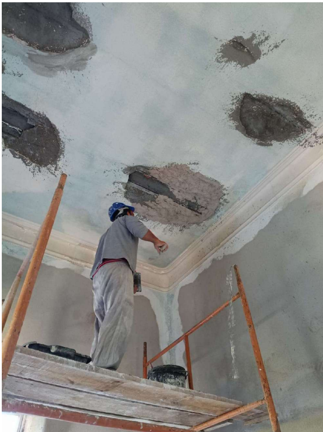
Foto 15 – Recuperação dos elementos metálicos do teto, e reintegração do reboco.
