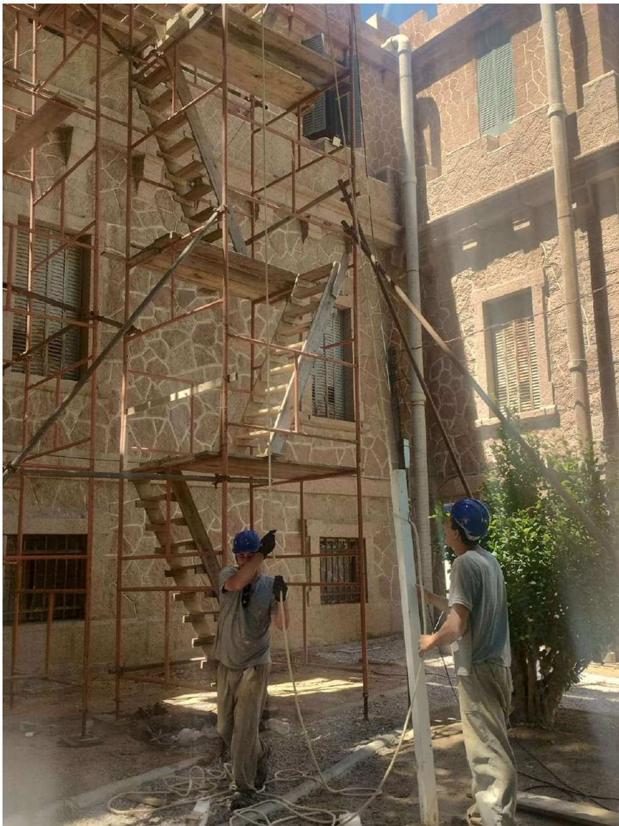
Foto 2 – Montagem andaimes, escada e plataformas no retorno em janeiro 2026.
