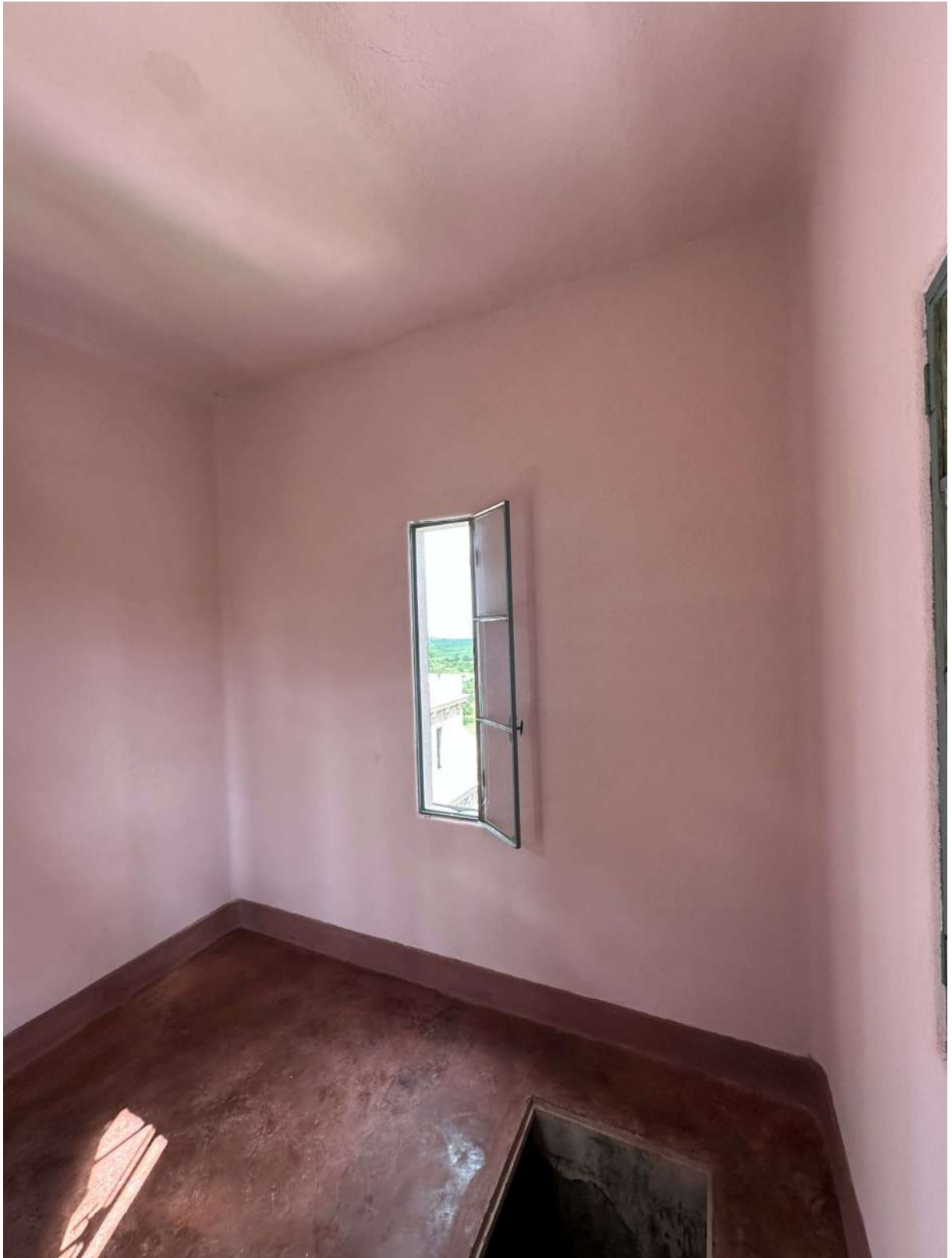
Foto 41 – Pintura tetos e paredes - Cor Couro Rosado – Tintas Coral.
