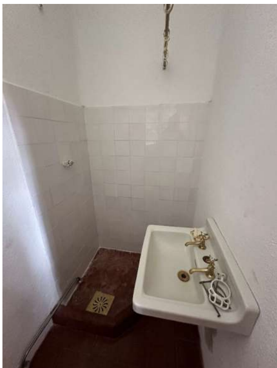
Foto 84 – Lavatório e metais limpos e instalados. Revestimento cerâmico recolocado.
