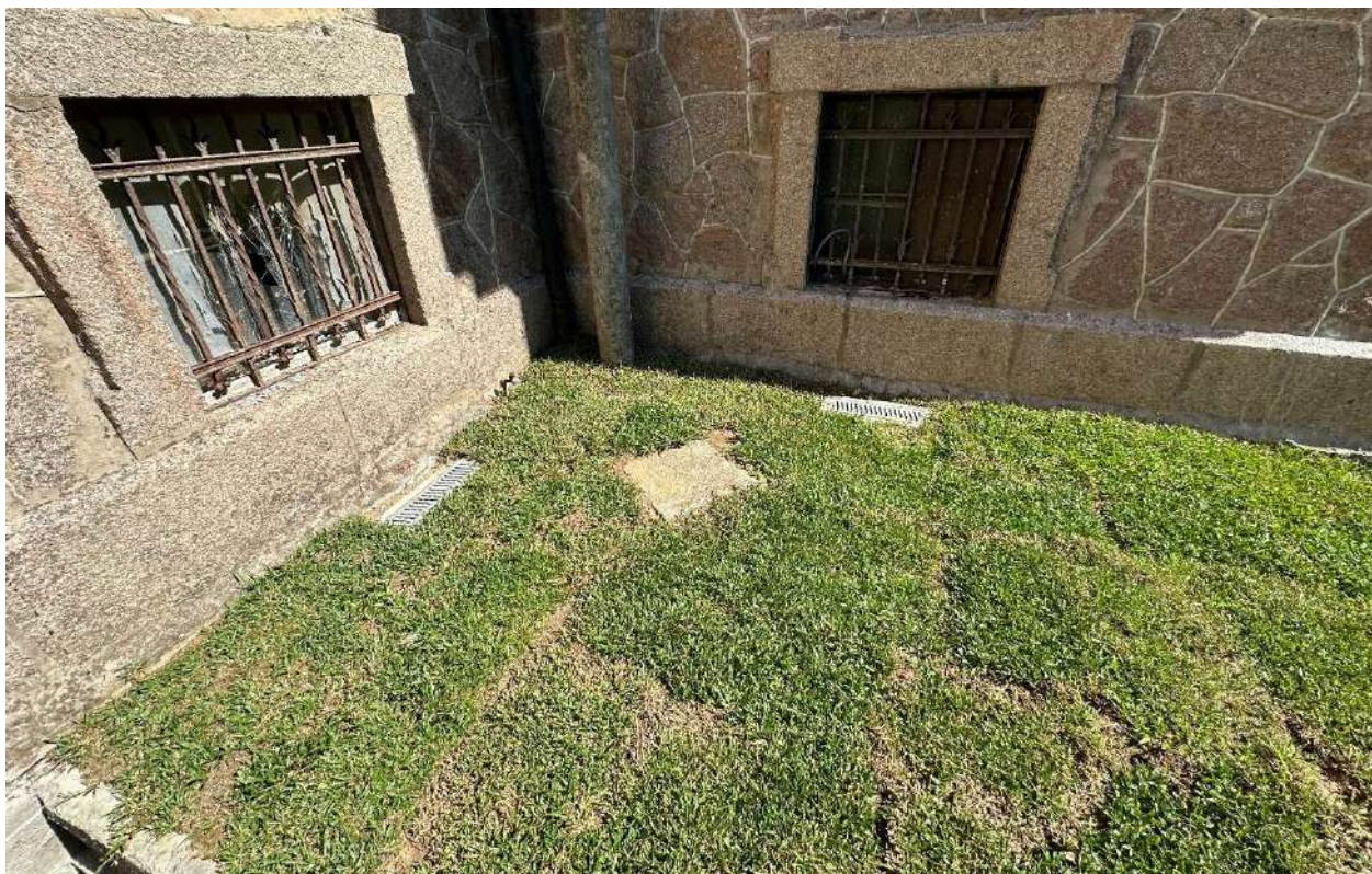
Foto 22 – Colocação de grama São Carlos.
