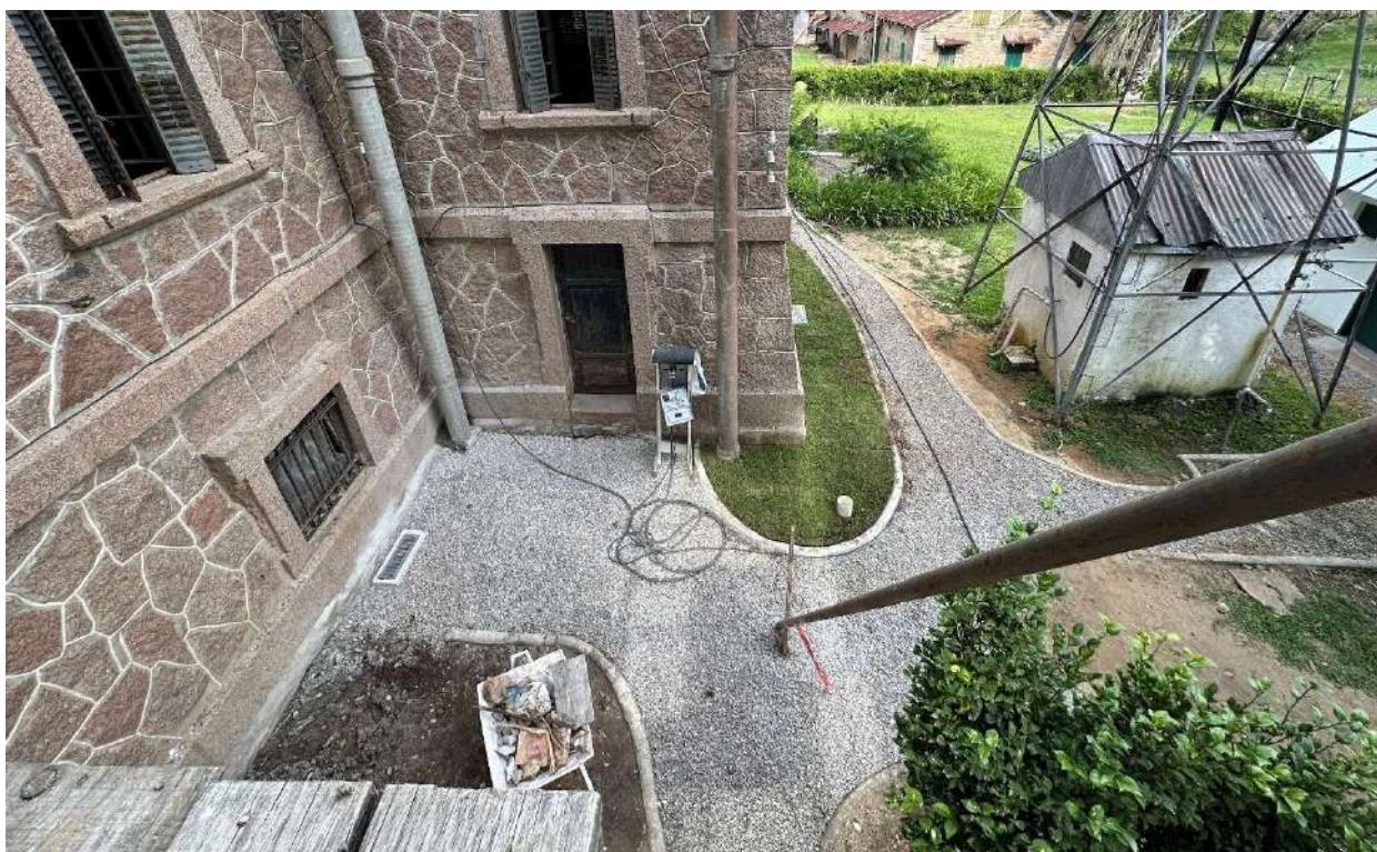
Foto 27 – Reconstrução dos cordões e caminhos com brita.
