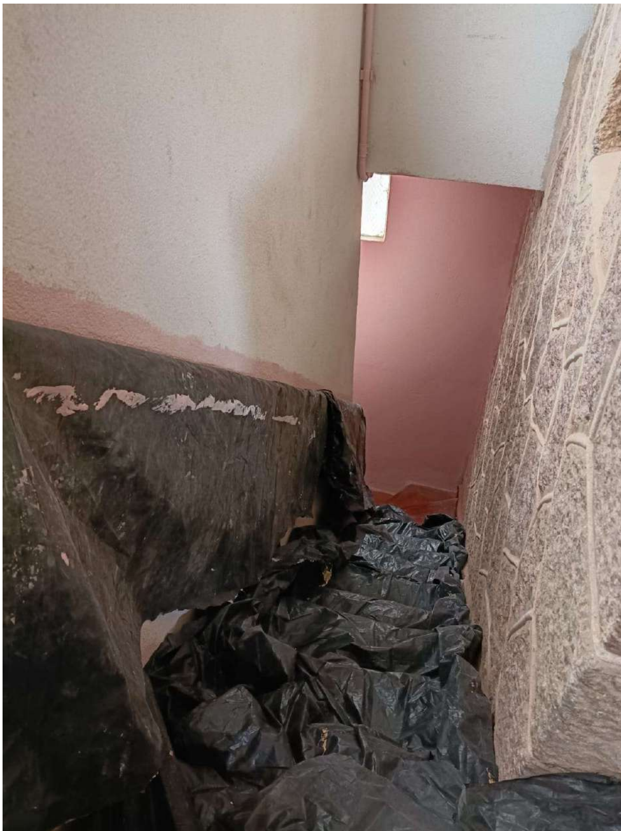
Foto 50 – Pintura paredes e tetos.
