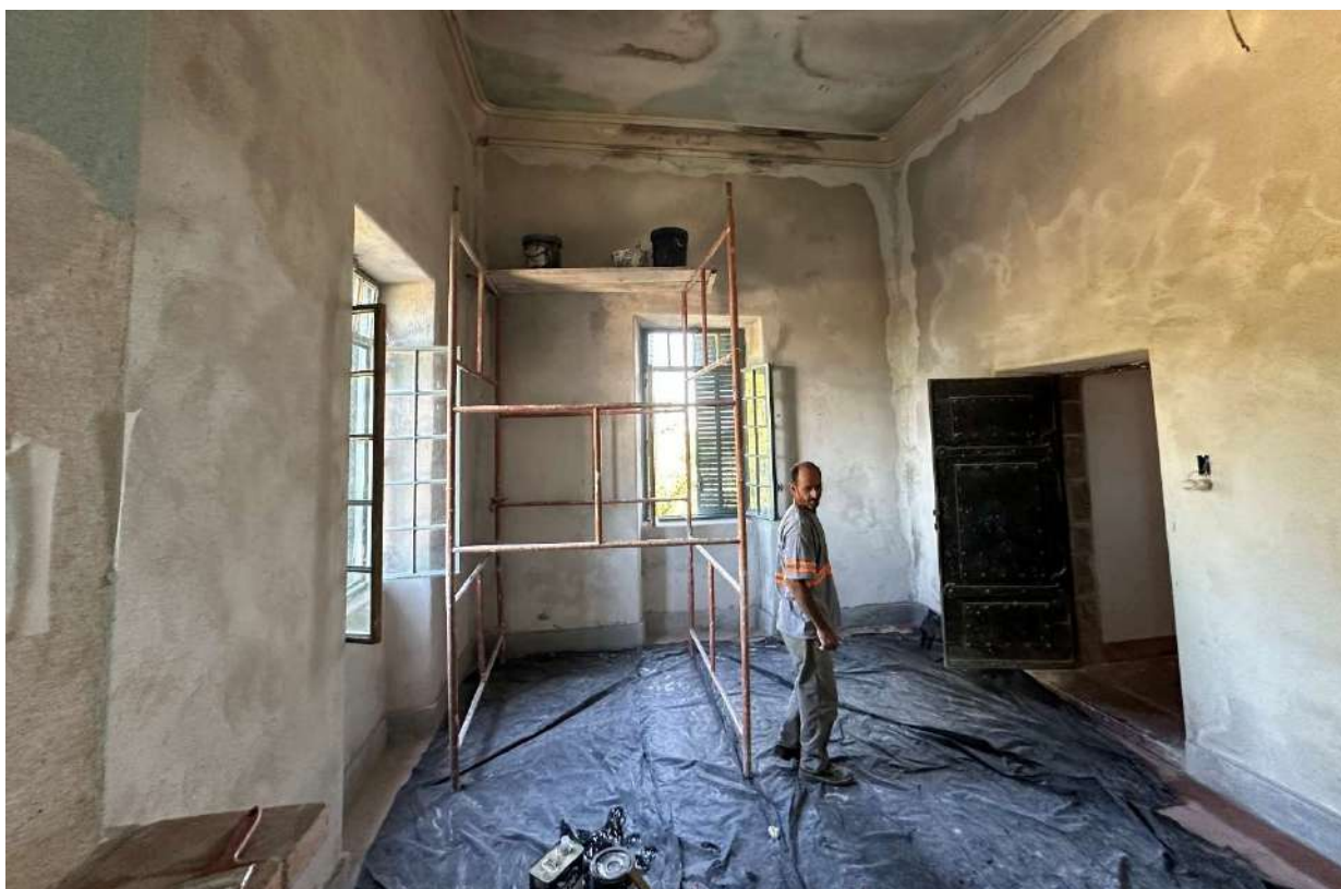
Foto 9– Execução rebocos.
