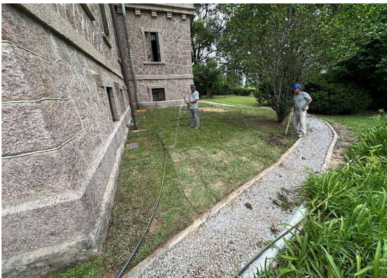
Foto 29 – Reconstrução dos cordões e caminhos com brita.
