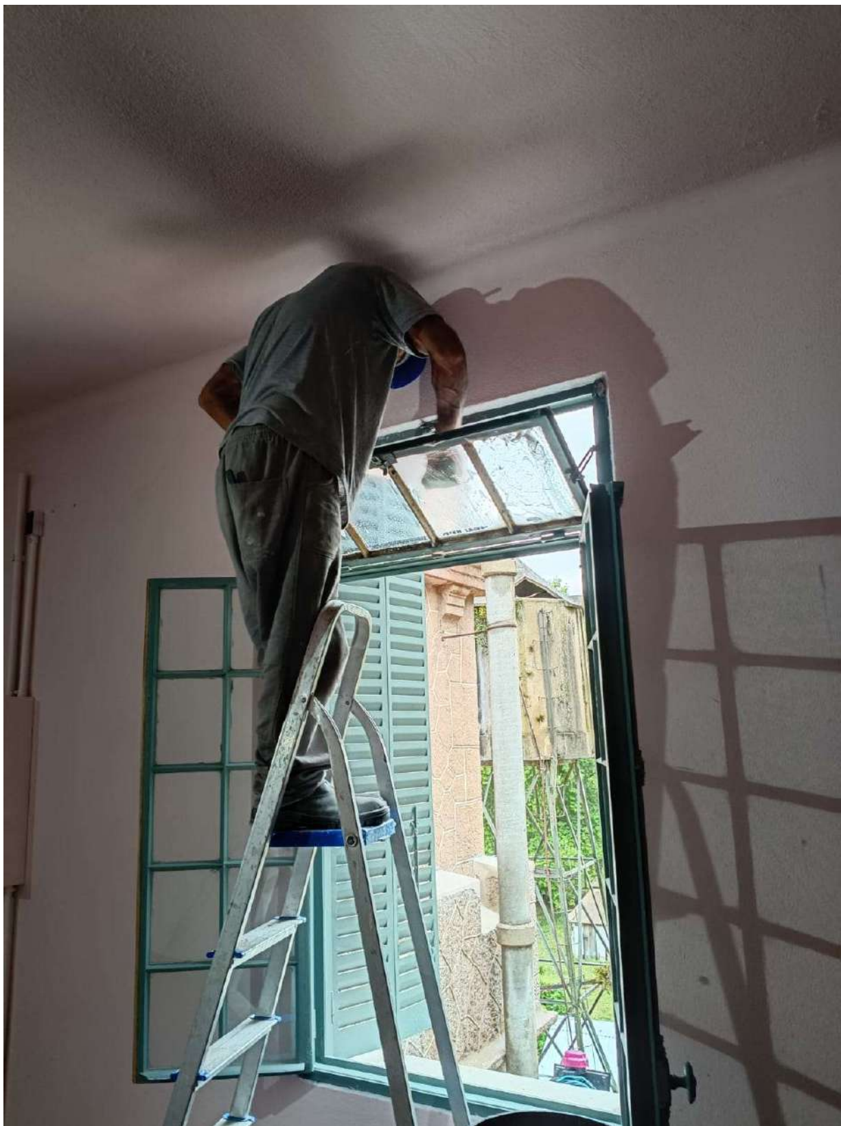
Foto 93 – Limpeza vidros e repintura das janelas metálicas.
