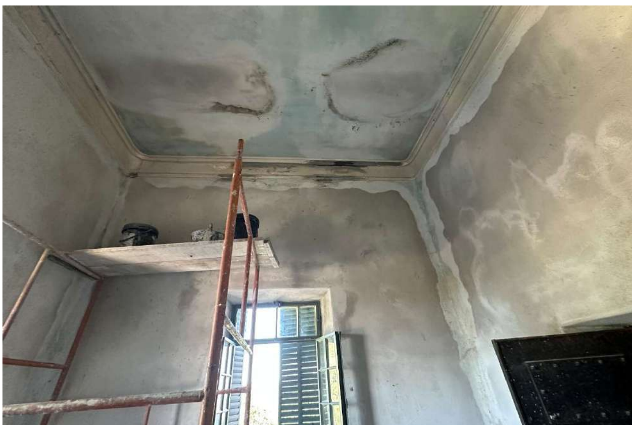
Foto 17 – Reintegração das molduras do teto.
