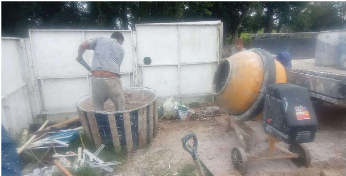
Foto 3 – Preparação da argamassa de cal e areia traço 1:3
