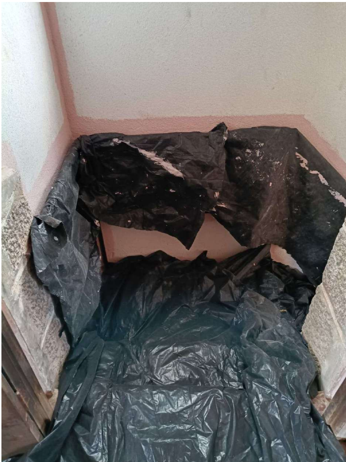
Foto 98 – Proteção escada com lona plástica.
