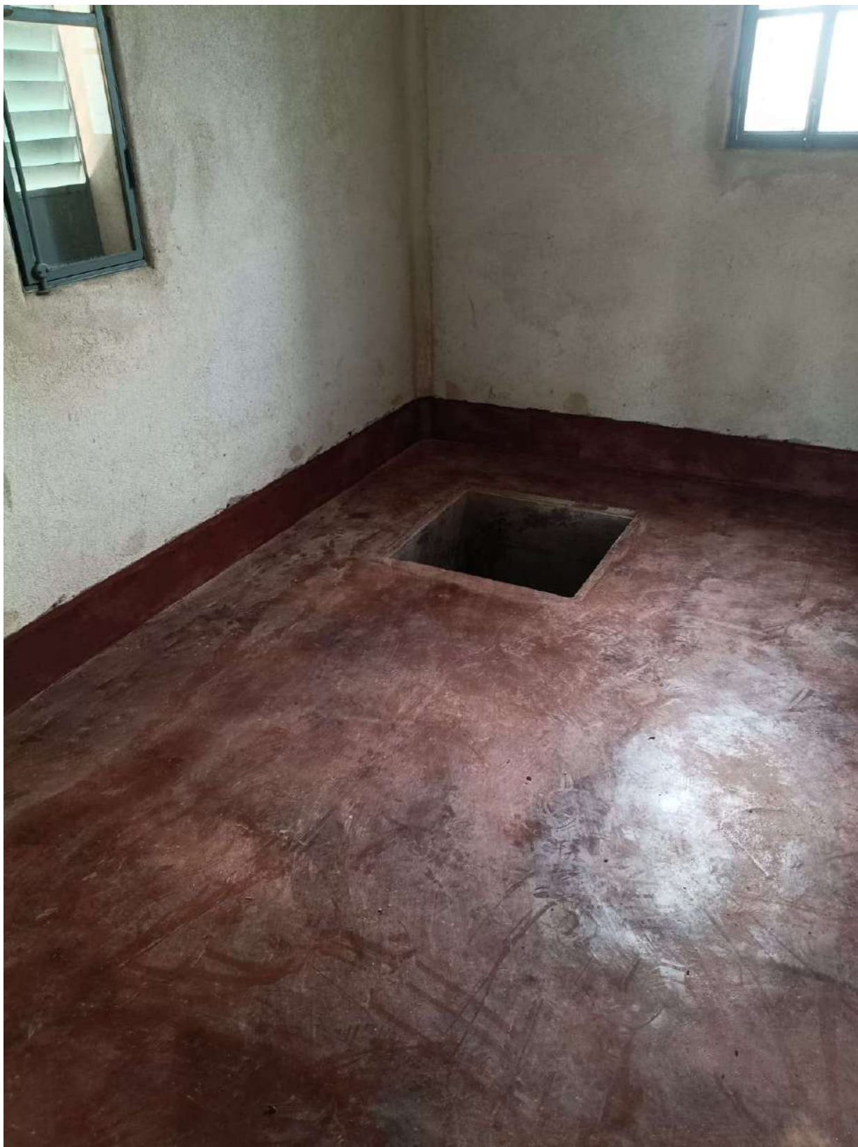
Foto 61 – Reintegração dos rodapés, limpeza piso 4. Nível. C52.
