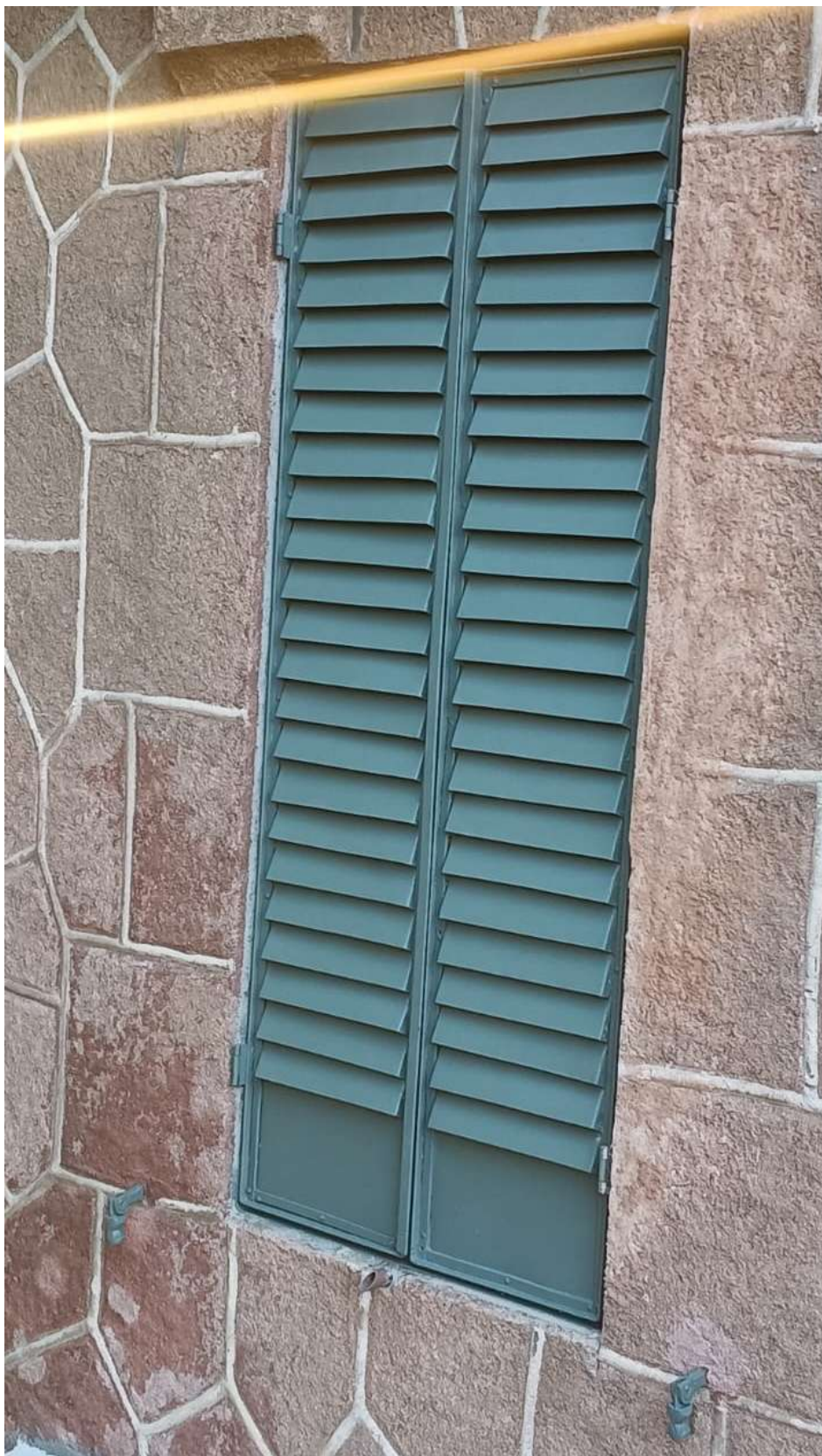
Foto 92 – Repintura das janelas metálicas.
