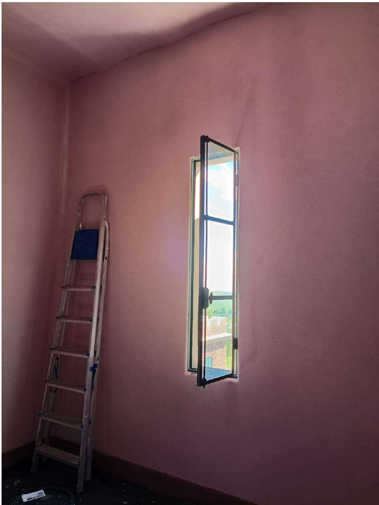
Foto 40 – Pintura tetos e paredes - Cor Couro Rosado – Tintas Coral.
