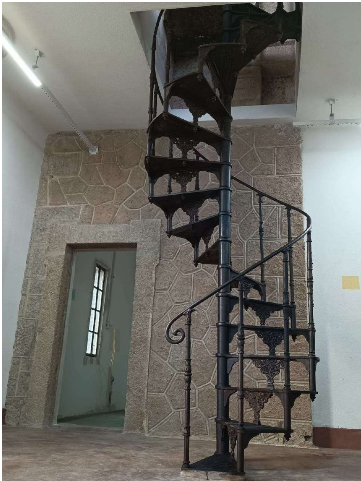
Foto 73 – Limpeza e aplicação de acabamento na escada.
