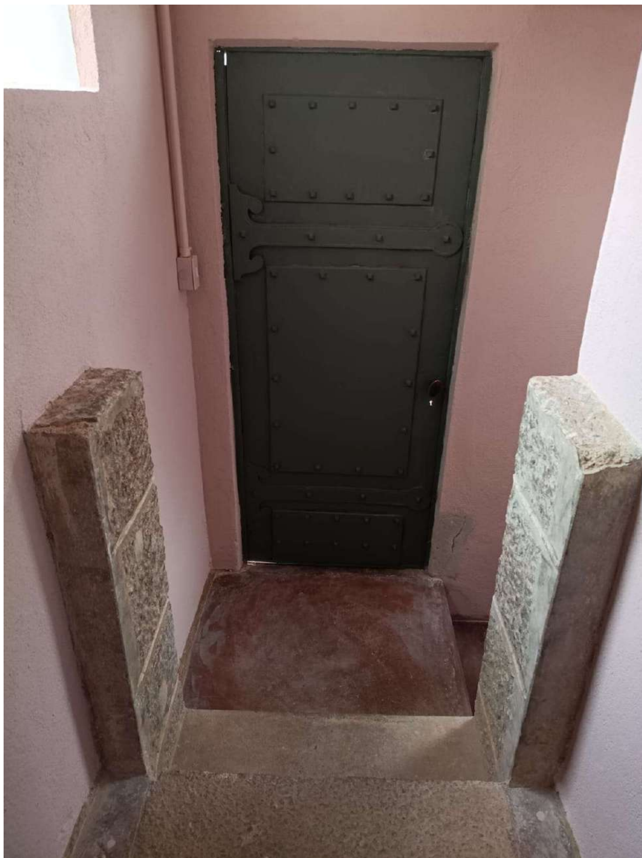
Foto 51 – Pintura paredes e tetos.
