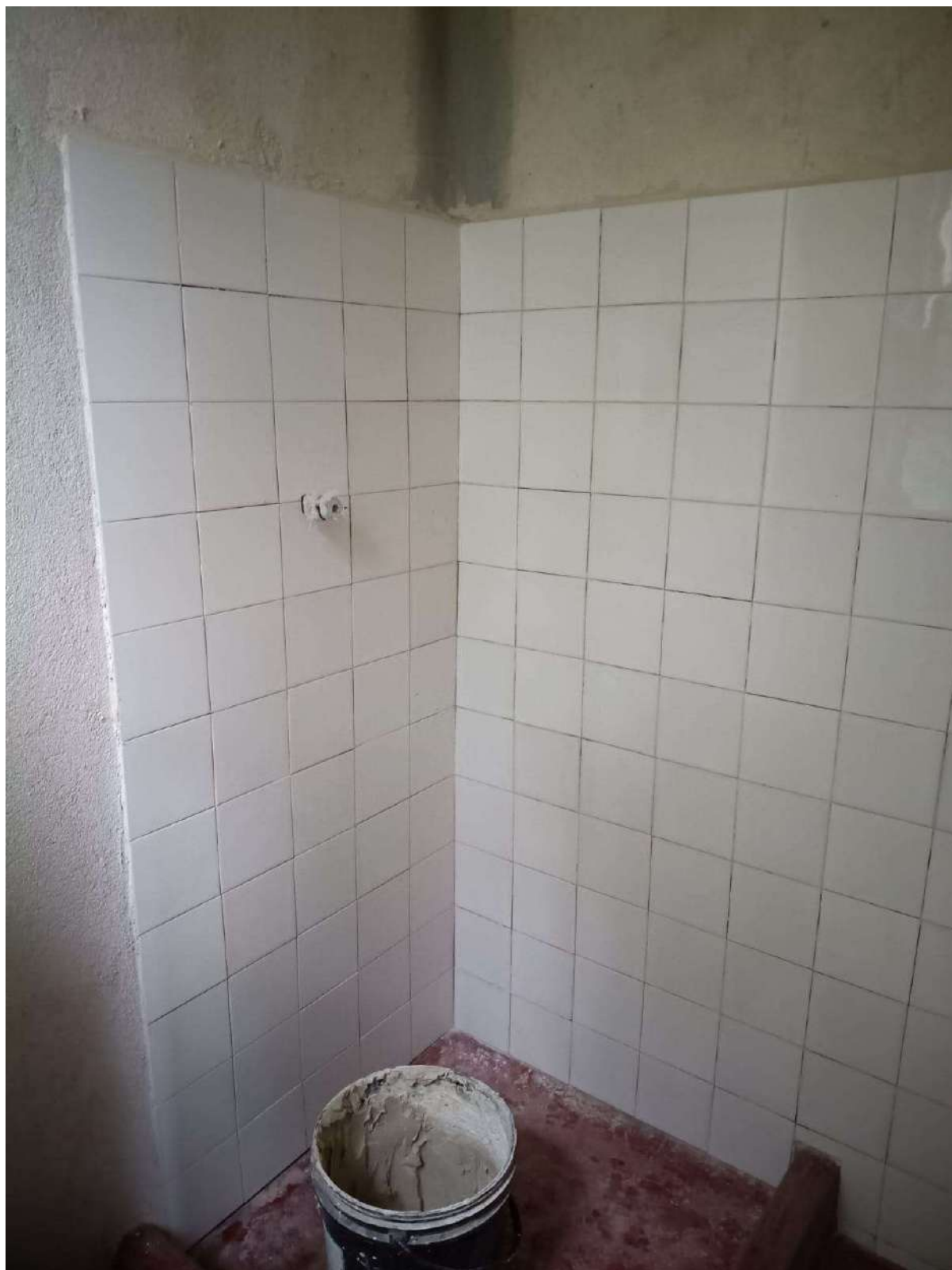
Foto 76 – Recolocação revestimentos cerâmicos após limpeza.
