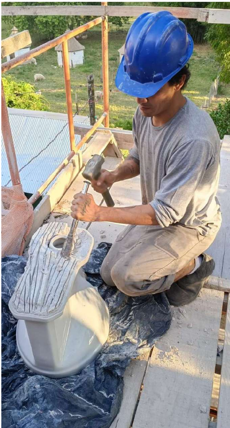
Foto 77 – Remoção cuidadosa da argamassa assentamento antiga das bacias sanitárias.
