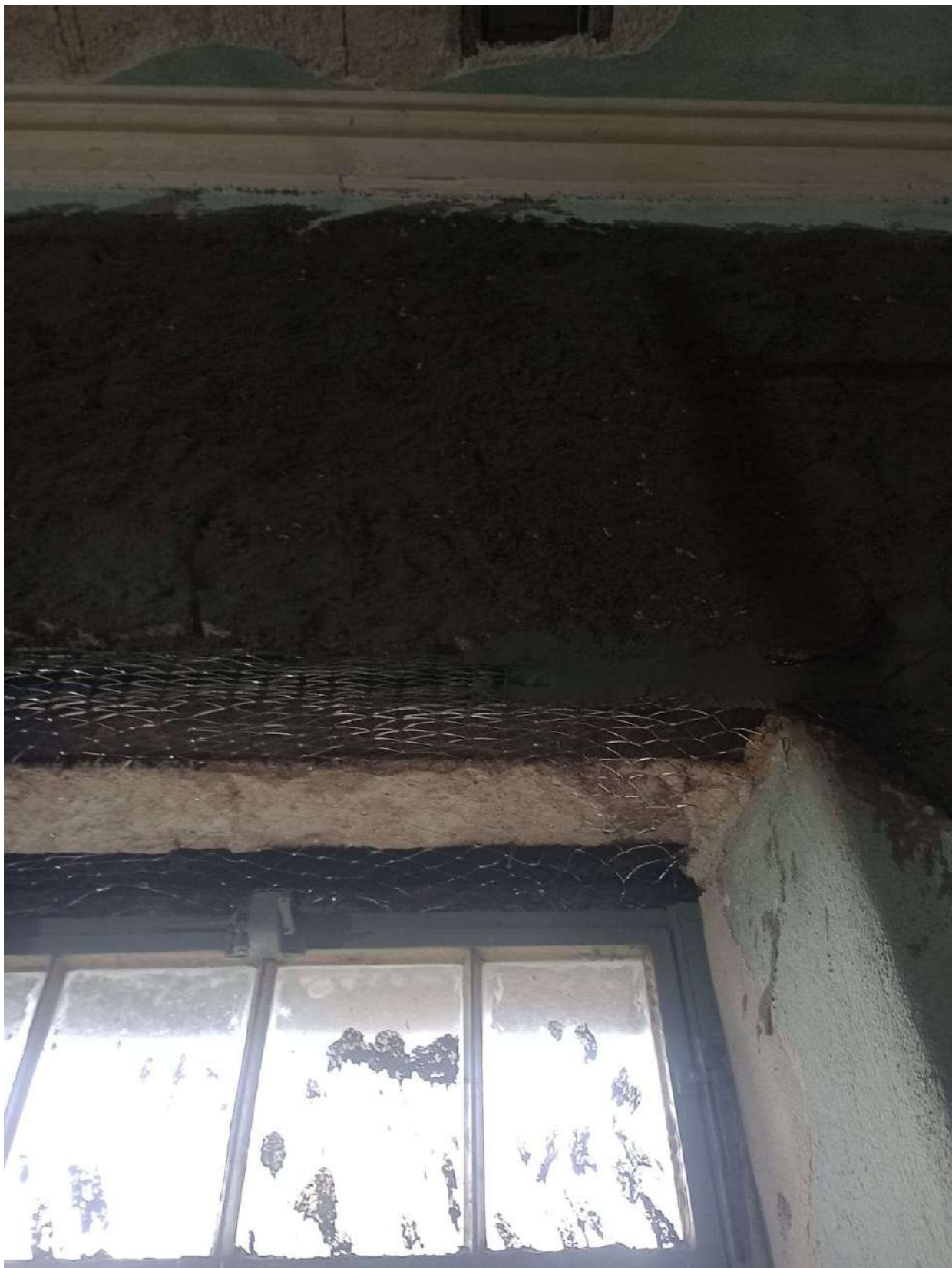
Foto 12 – Recuperação das peças metálicas das vergas das janelas, colocação de tela de estuque e reconstituição do reboco.
