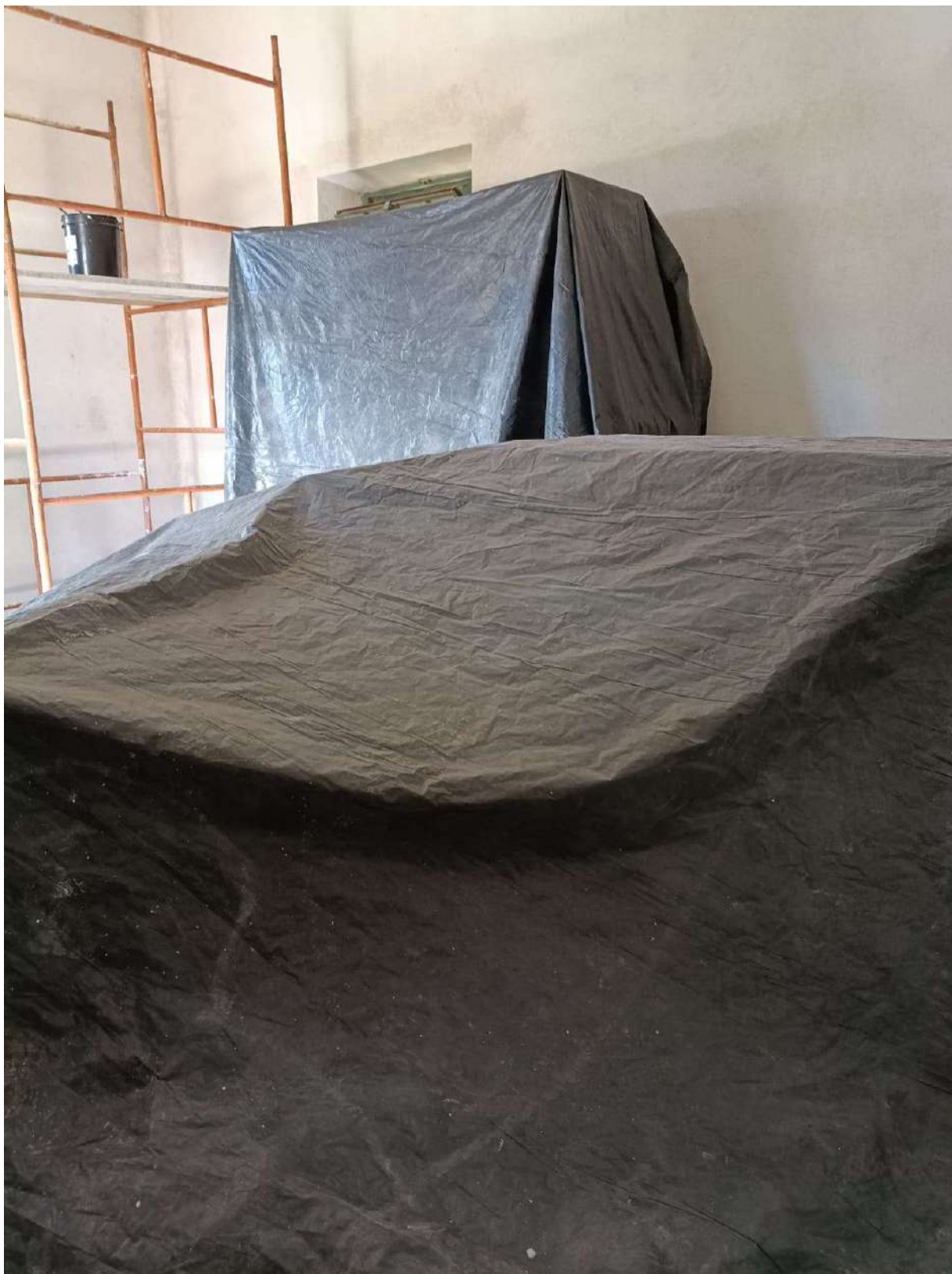
Foto 96 – Proteções móveis com lonas.
