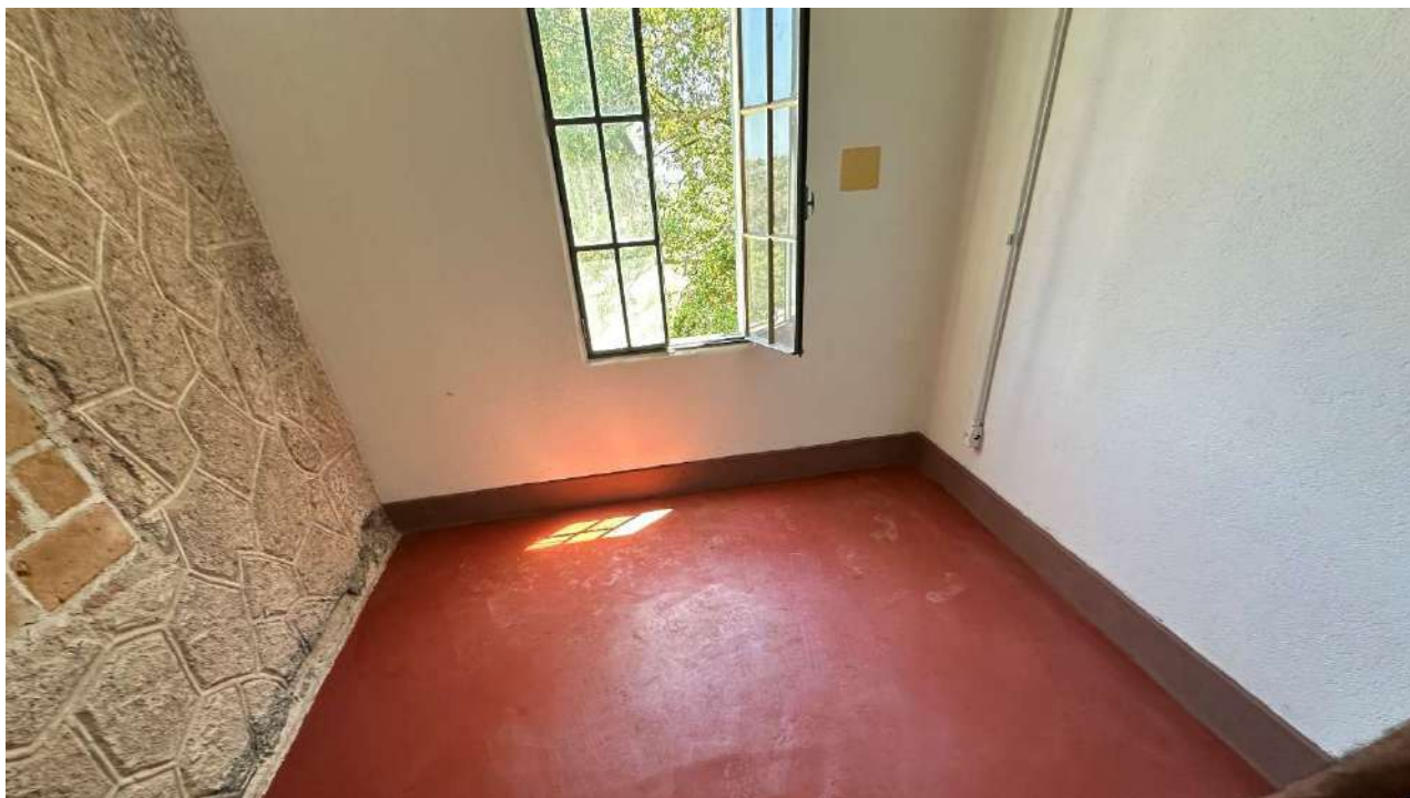
Foto 65– Reintegração rodapés e limpeza piso. 3. Nível – C49
