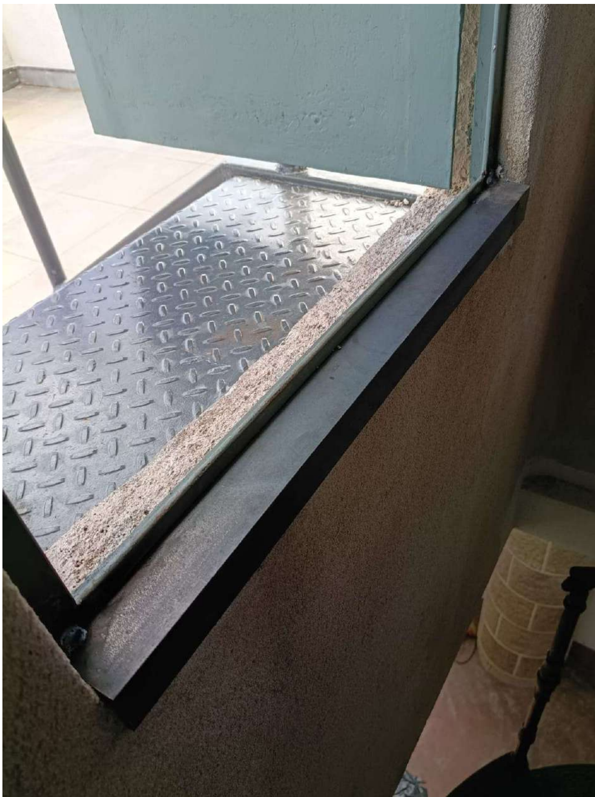
Foto 68 – Instalação de cantoneira arremate porta acesso terraço junto a escada caracol C47.
