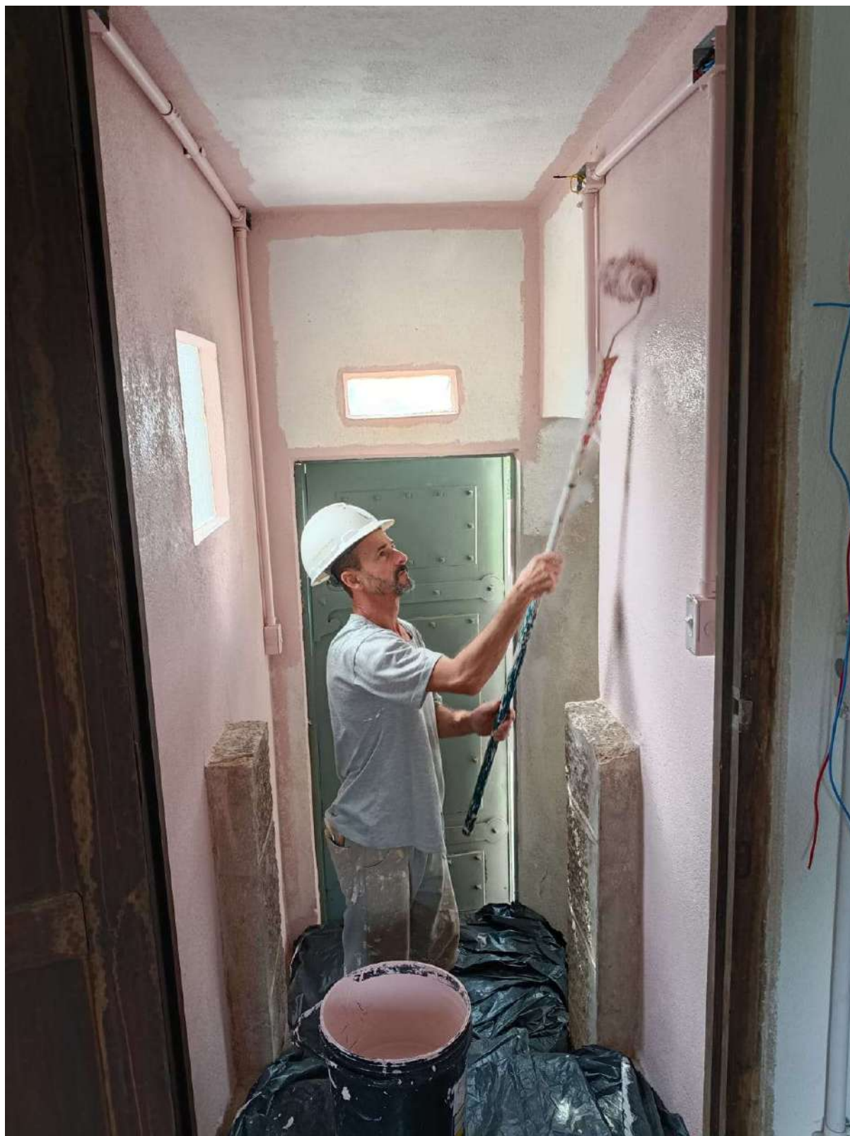
Foto 49 – Pintura paredes e tetos.
