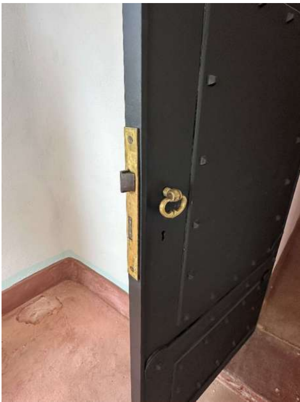
Foto 59 – Recuperação e pintura porta metálica C39. Recuperação da fechadura e puxador.
