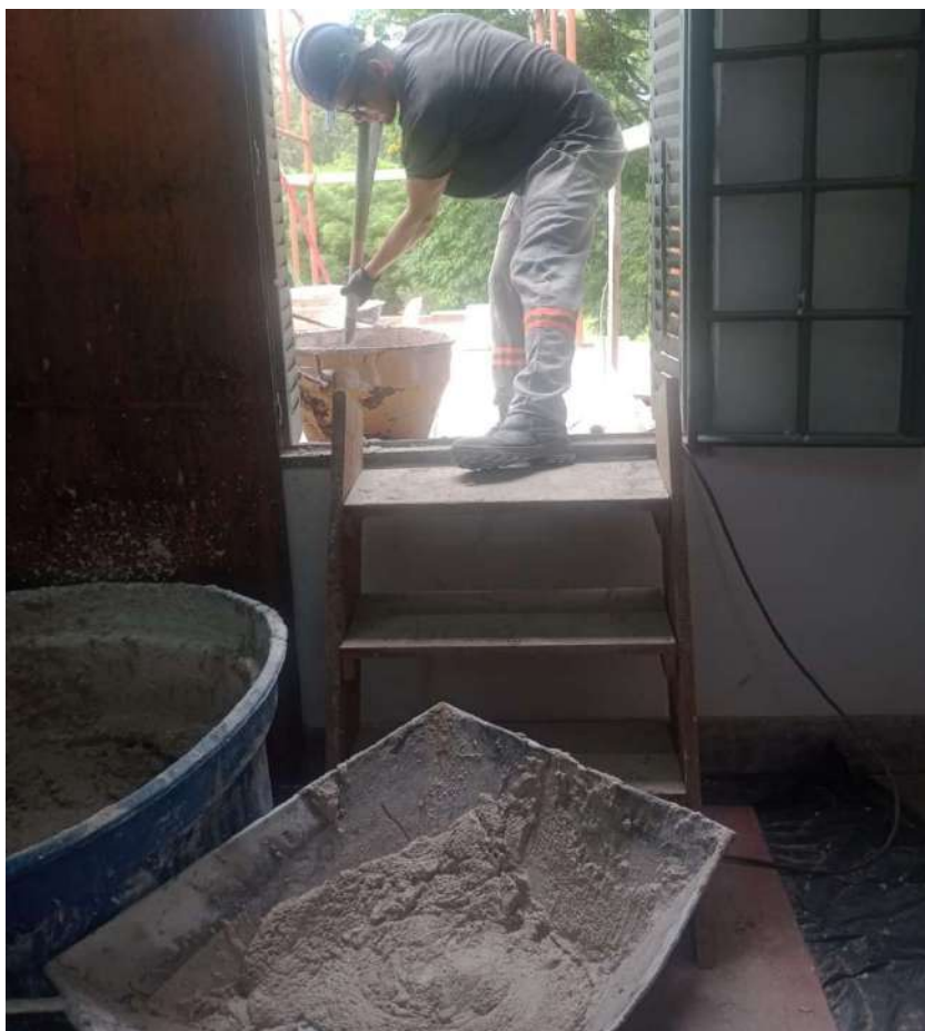
Foto 4 – Transporte da argamassa.
