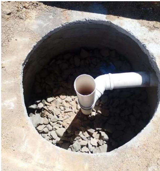
Foto 30 – Tubulações internas e brita dentro do filtro.
