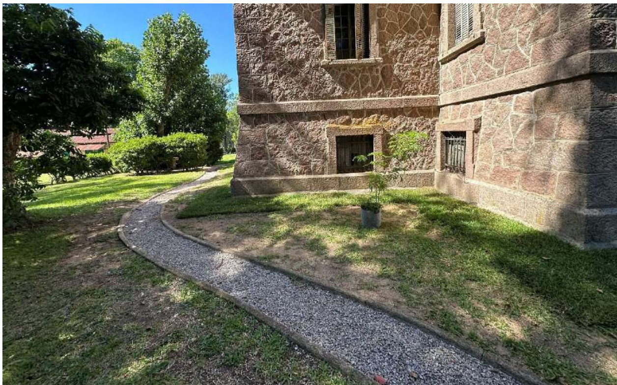
Foto 28 – Reconstrução dos cordões e caminhos com brita.
