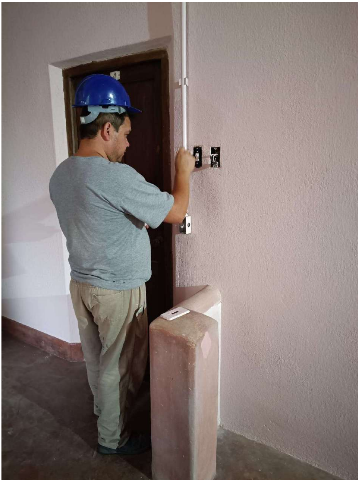
Foto 36 – Remoção das redes instaladas.
