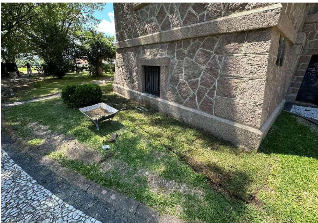
Foto 19 – Colocação de grama São Carlos.
