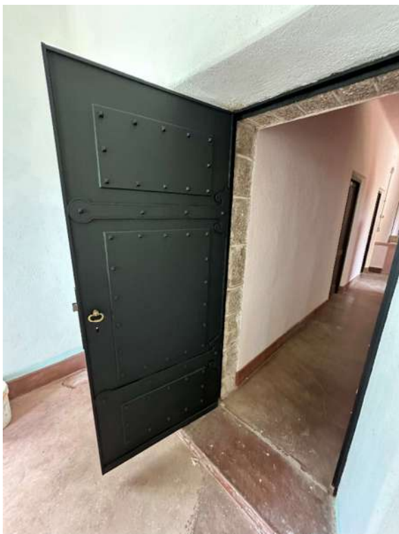
Foto 58 – Recuperação e pintura porta metálica C39.
