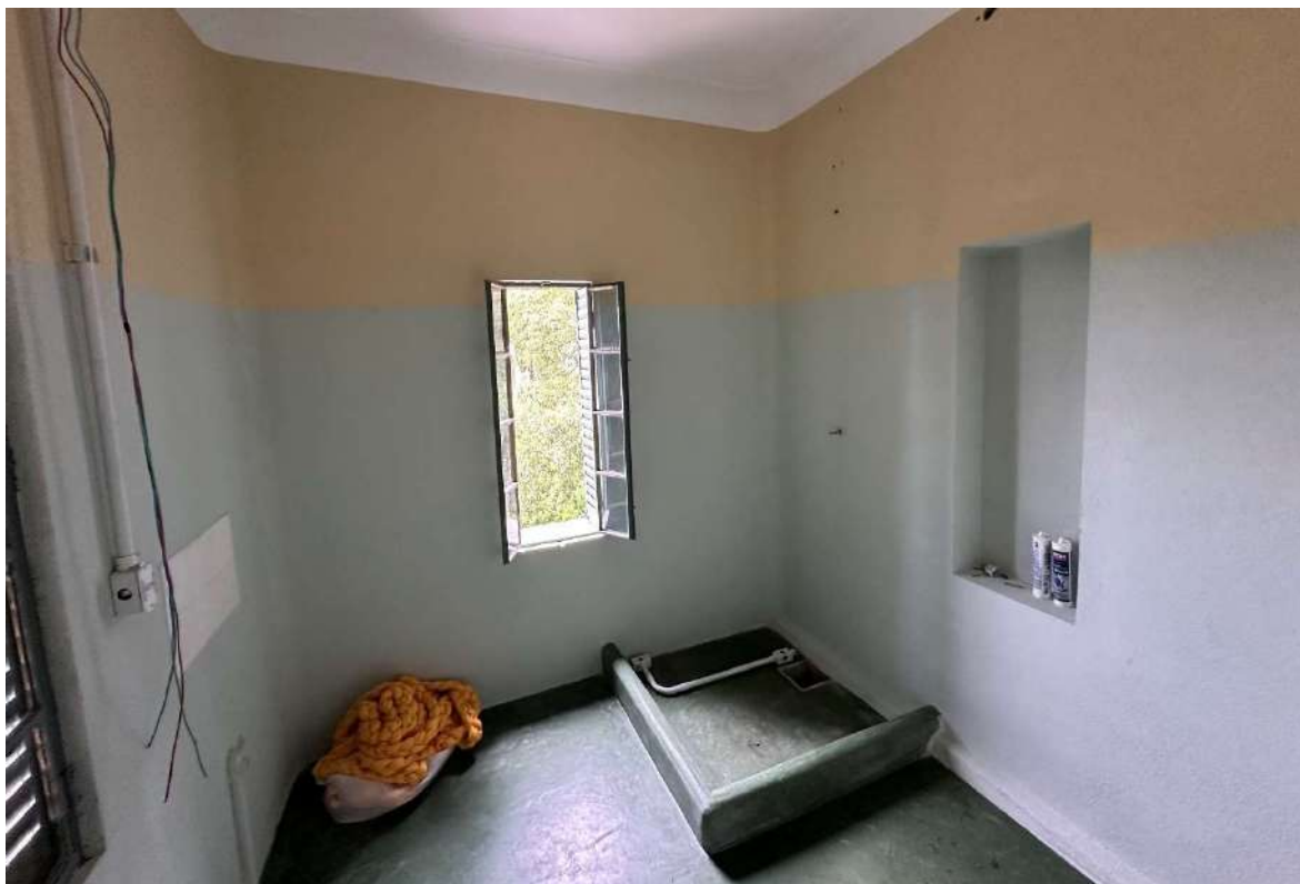
Foto 43 – Pintura paredes e tetos.
