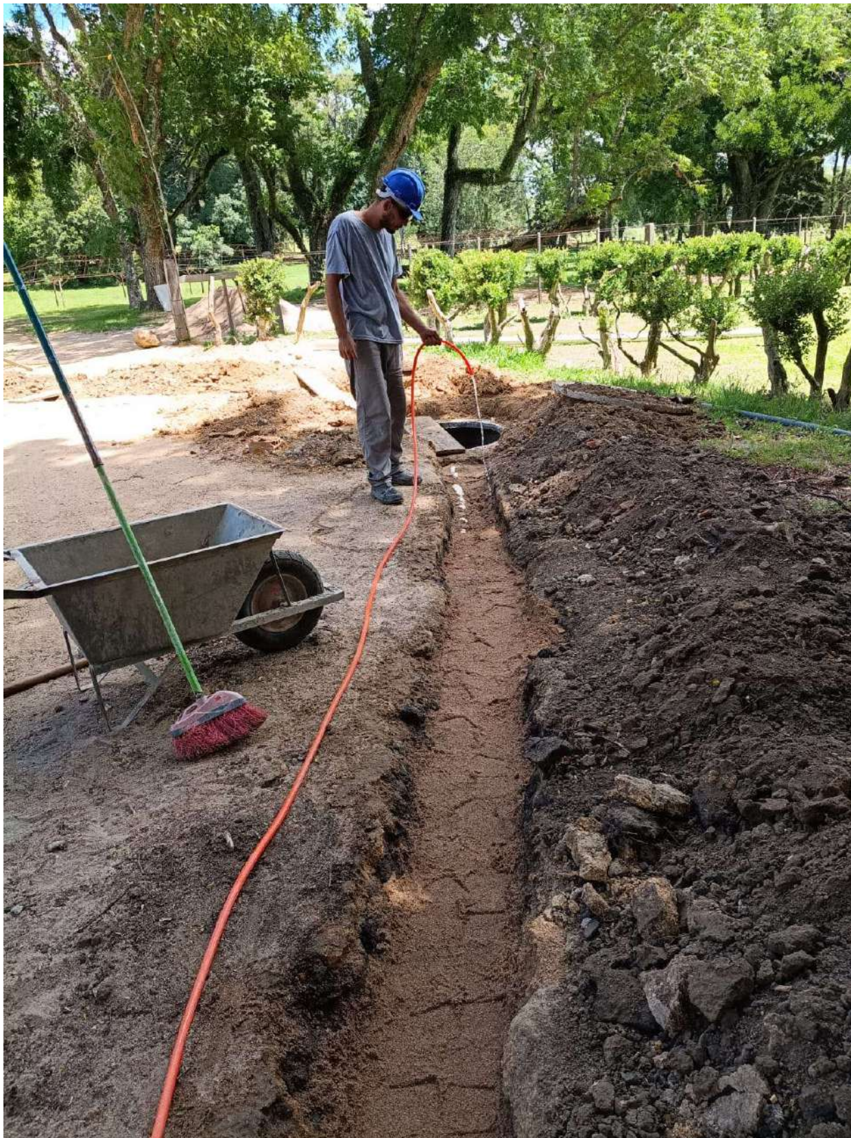
Foto 33 – Rede PVC 00 mm da caixa de inspeção do castelo até a fossa.
