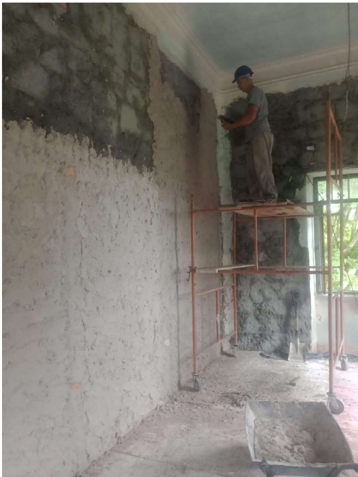
Foto 7 – Execução reboco.
