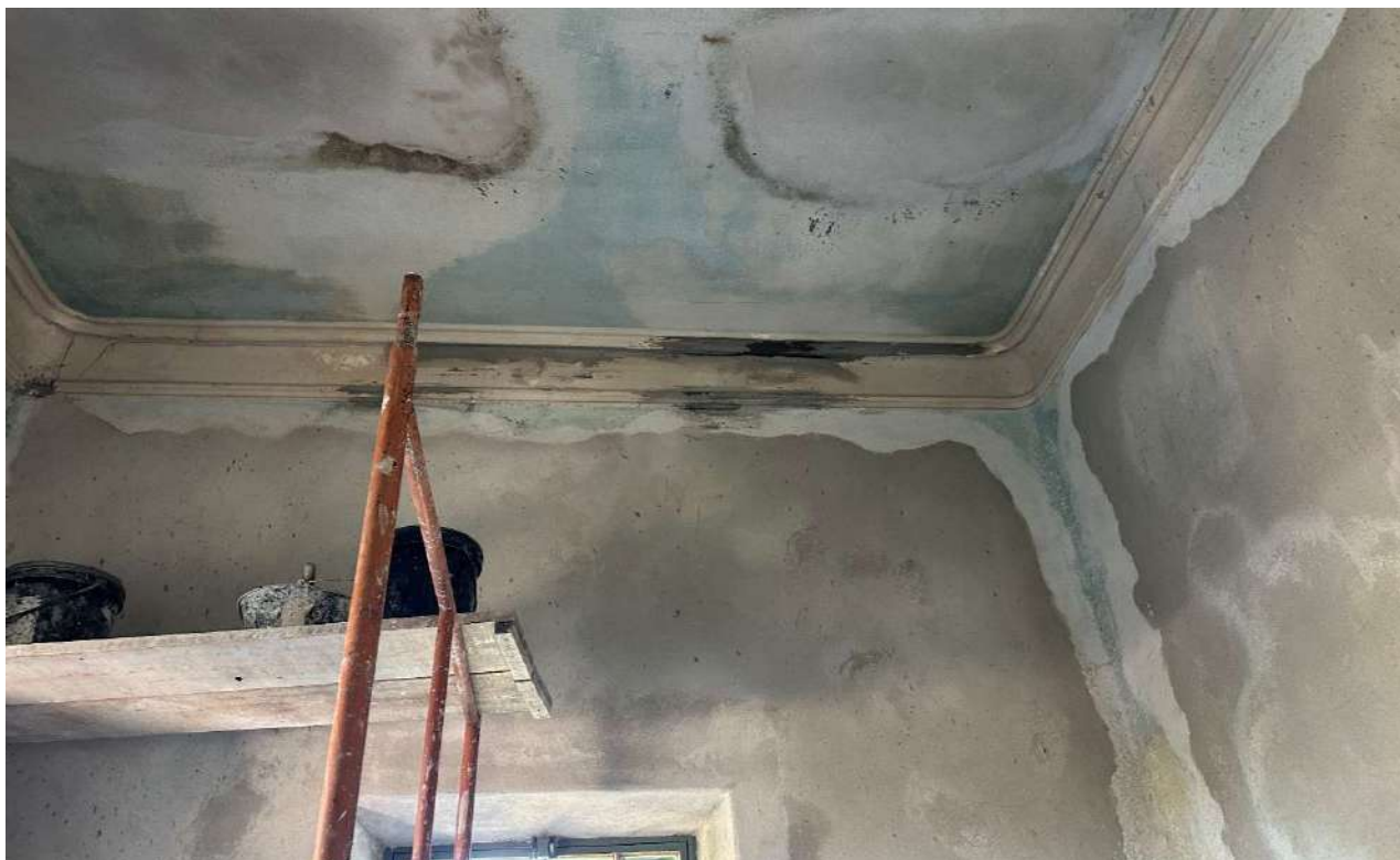
Foto 16 – Reintegração das molduras do teto.
