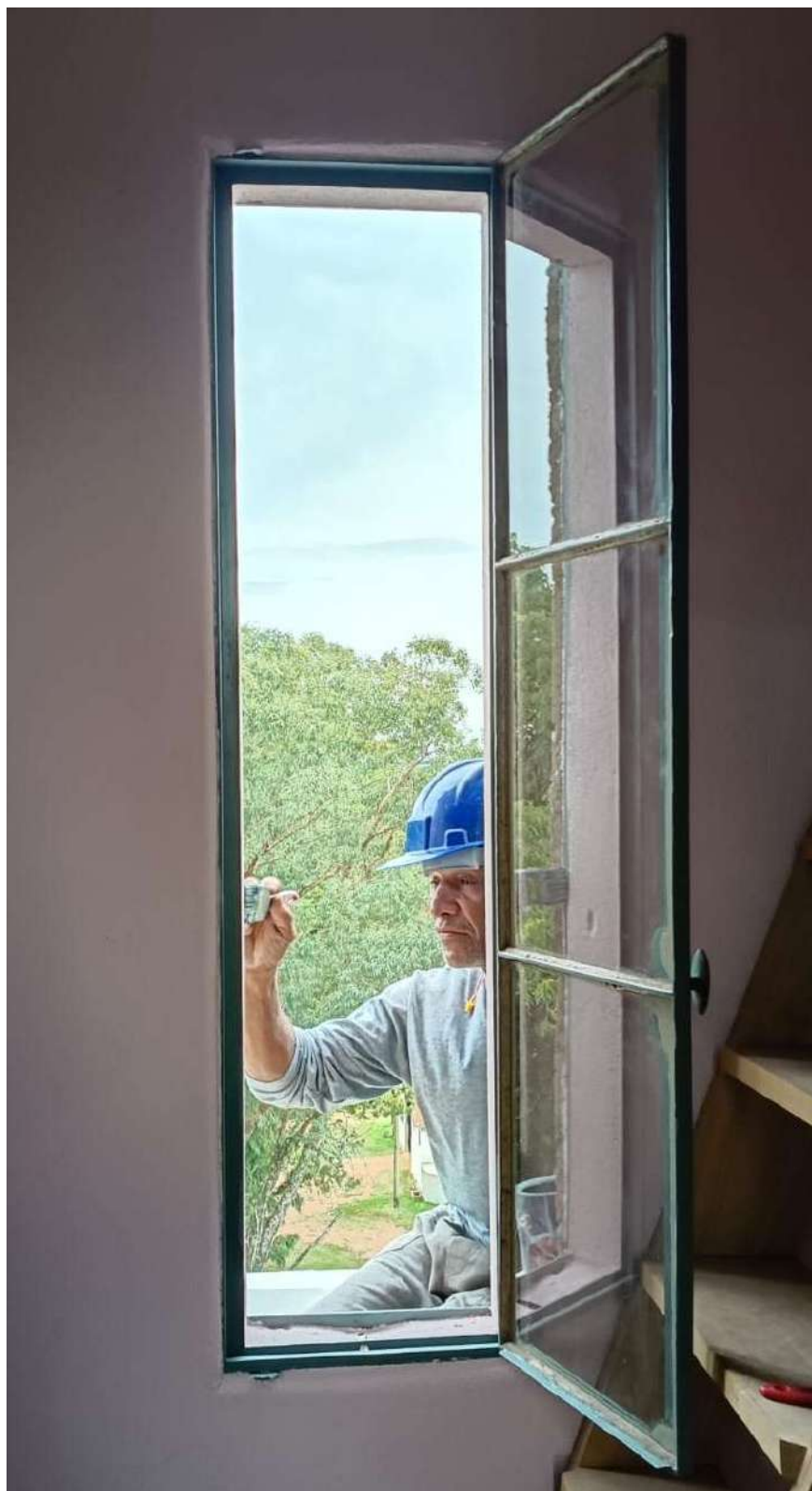
Foto 91 – Repintura das esquadrias.
