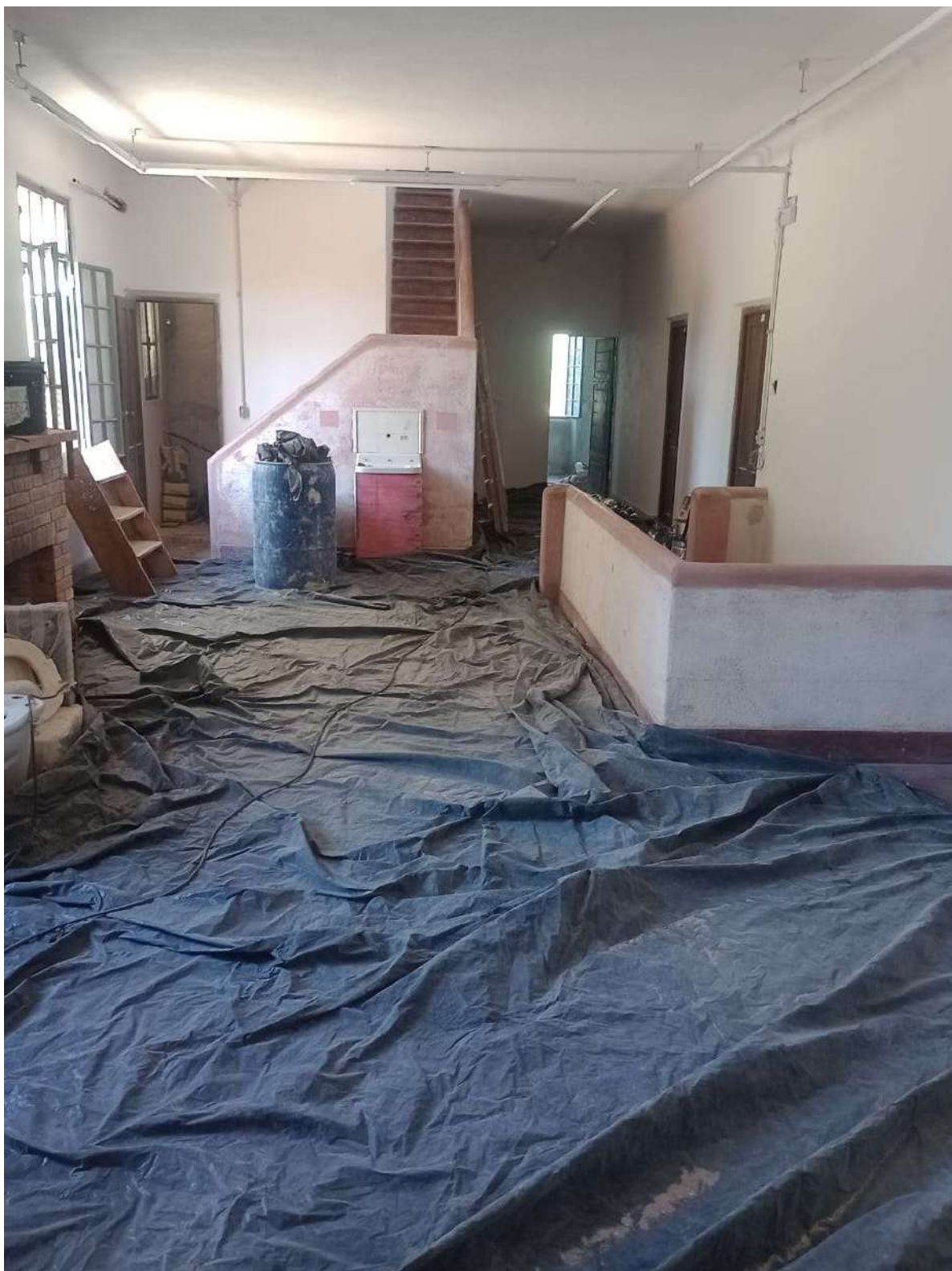
Foto 95 – Proteções pisos com lonas.
