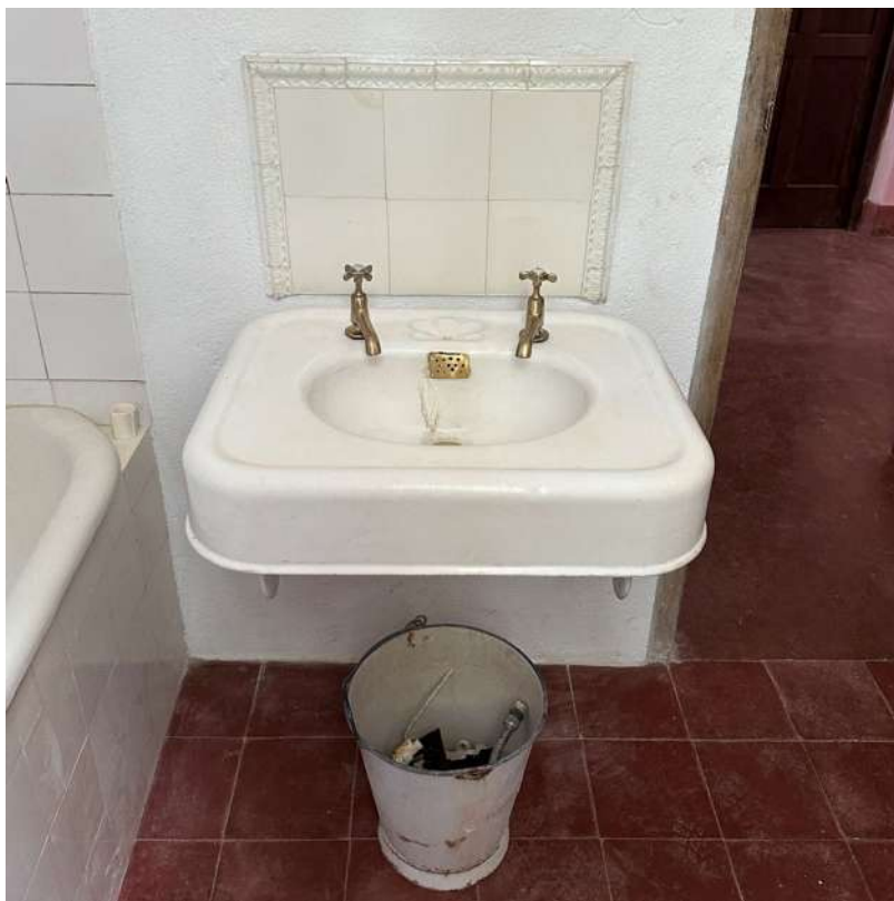
Foto 81 – Lavatório e metais limpos e recolocados.
