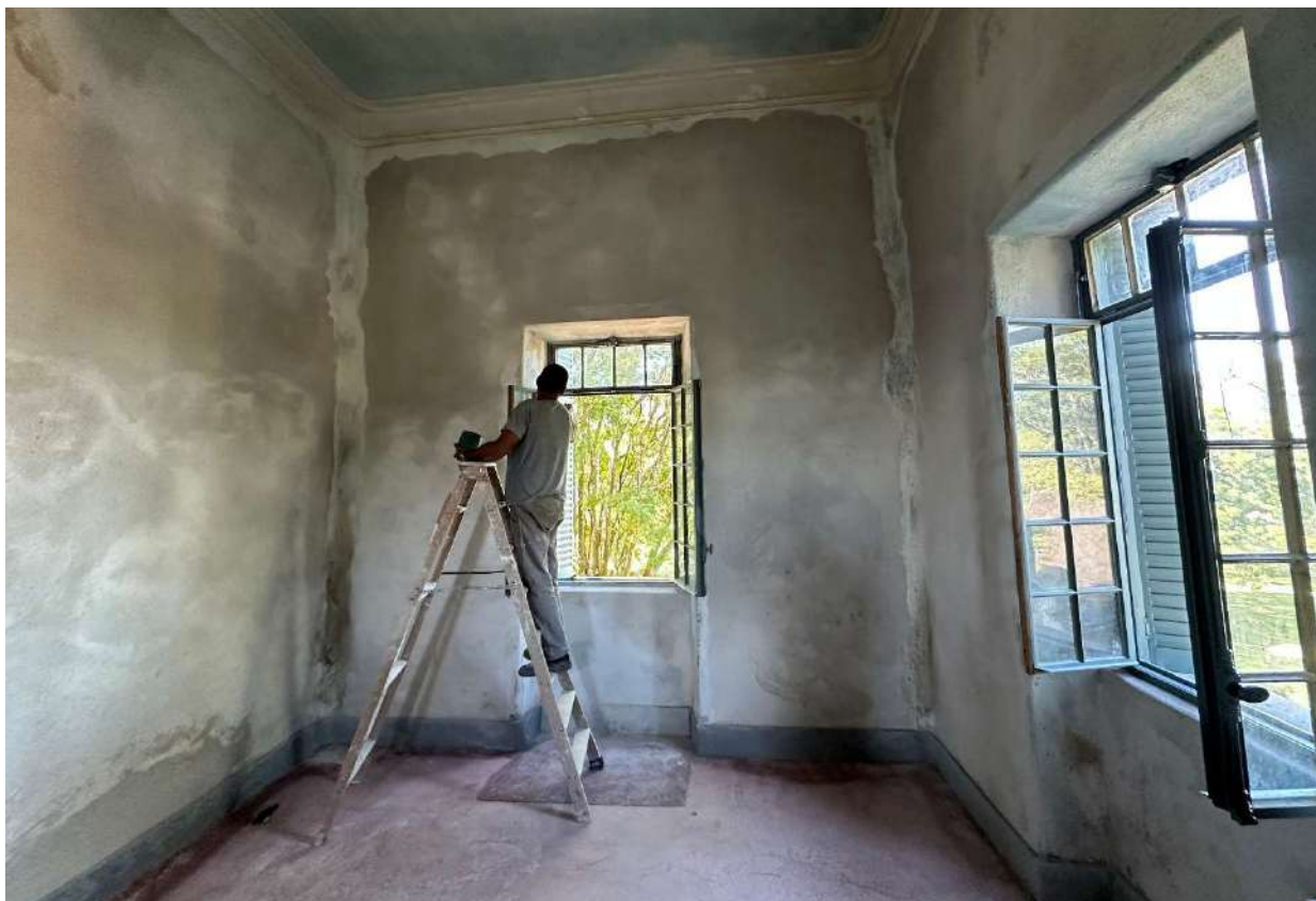
Foto 10 – Execução rebocos.
