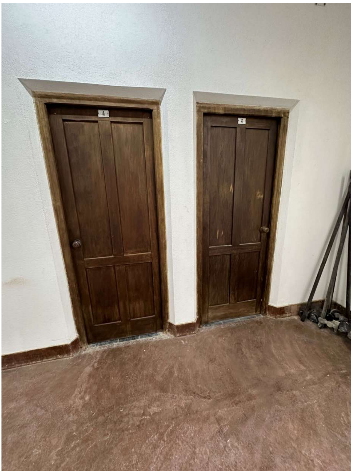
Foto 57 – Aplicação de selador nas portas de madeira internas.
