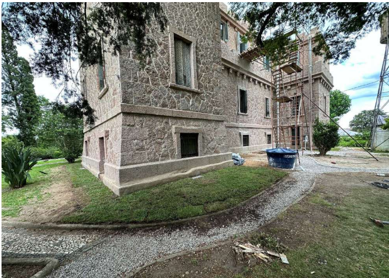
Foto 20 – Colocação de grama São Carlos.
